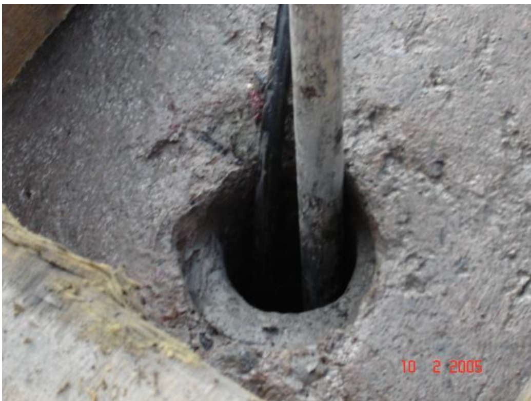
Fig 3.11.1 inyectando lechada en barreno.
