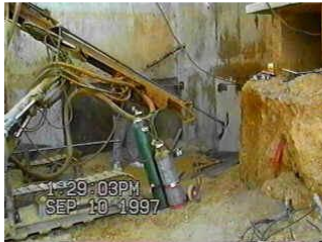
Fig. 3.2.2. Perforación para pantalla profunda
