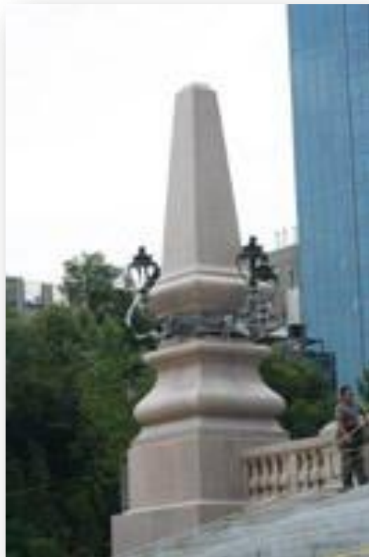
Fotografías No. 47. Detalle de la restauración de elementos decorativos.
