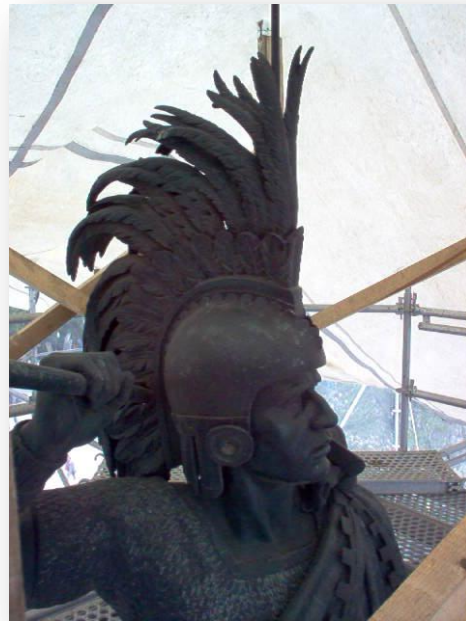
Fotografía No. 33 y 34 Detalles de la restauración de la escultura de Cuauhtémoc.
