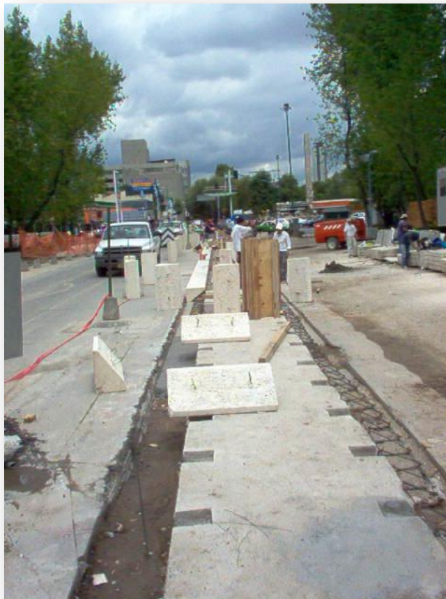
Fotografía No. 30 Detalle de piezas prefabricadas.
