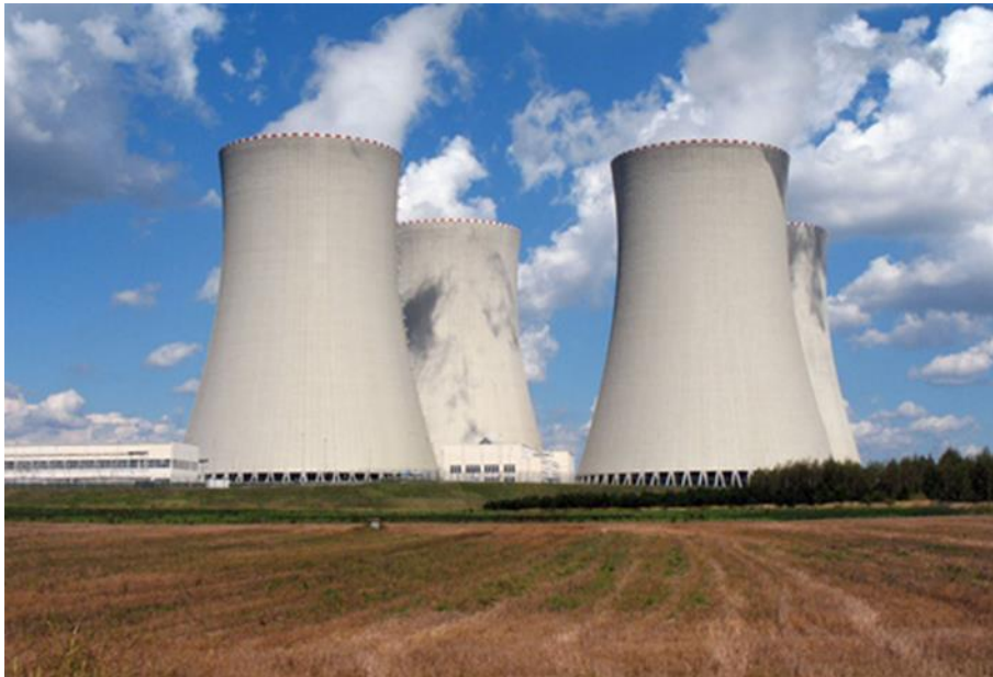
Figura 1.11 Vapor de las torres de enfriamiento.
