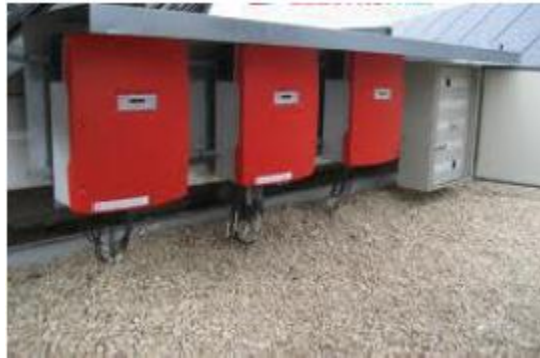
Figura 15 - Ejemplo de inversores
