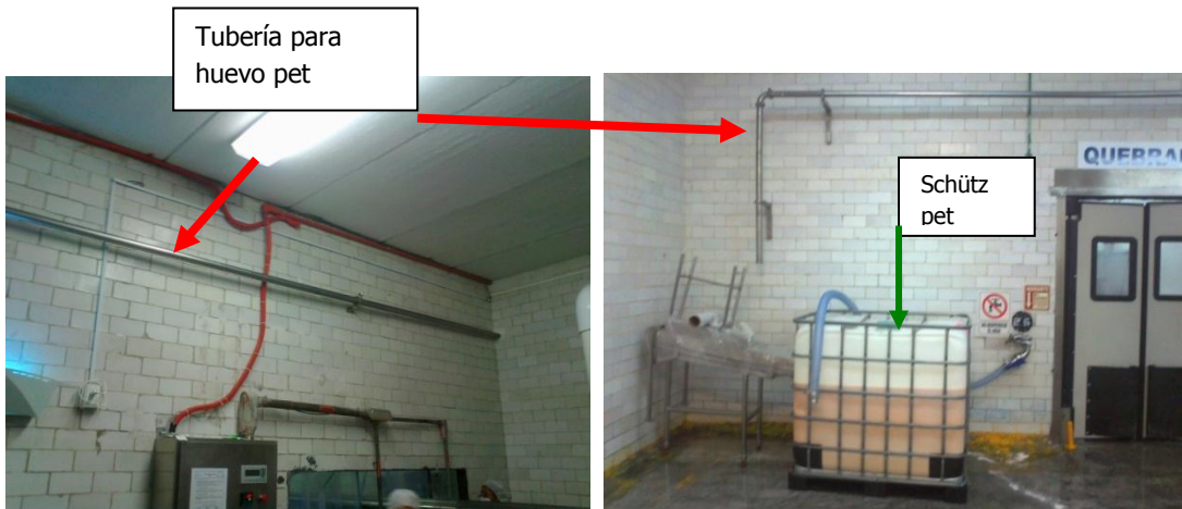
Figura 10 Instalación de la Tubería para huevo de Centrífuga No Apto para Consumo Humano
