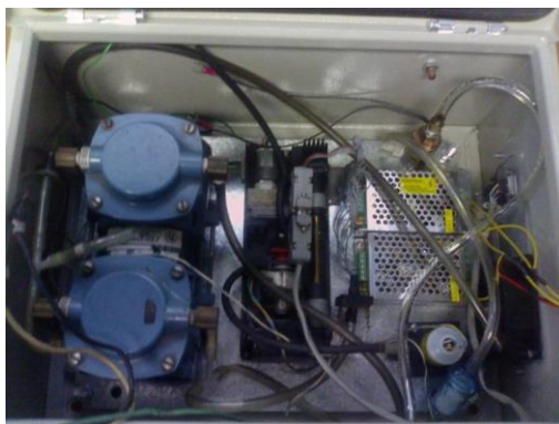
Figura 2.2.4.- Banca analizadora de gases ANDROS 6600.
