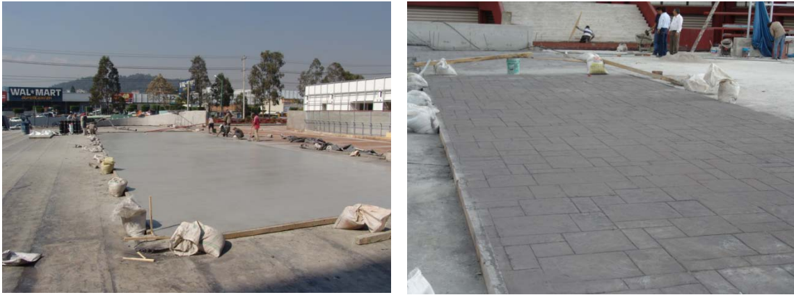
Colado del concreto planchado
