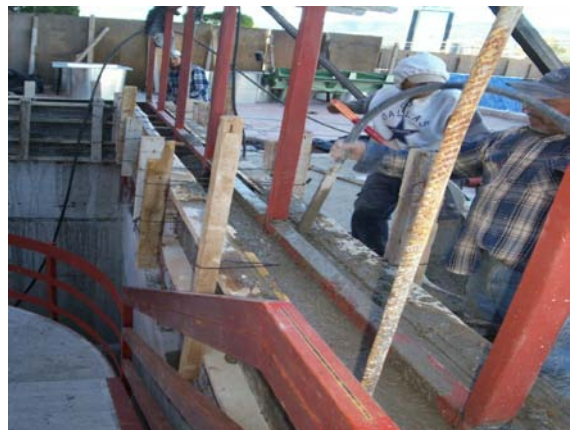
Cimbrado y colado del muro de desplante de la estructura para la cubierta de la escalera metálica ubicada en la entrada a los consultorios y estacionamientos.
