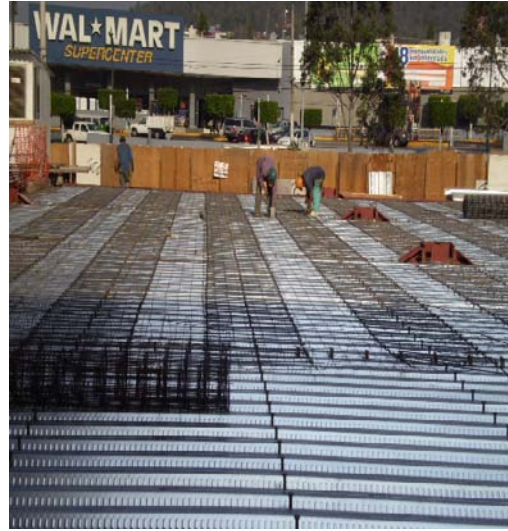
Placas base para la estructura y colocación de malla electrosoldada.
