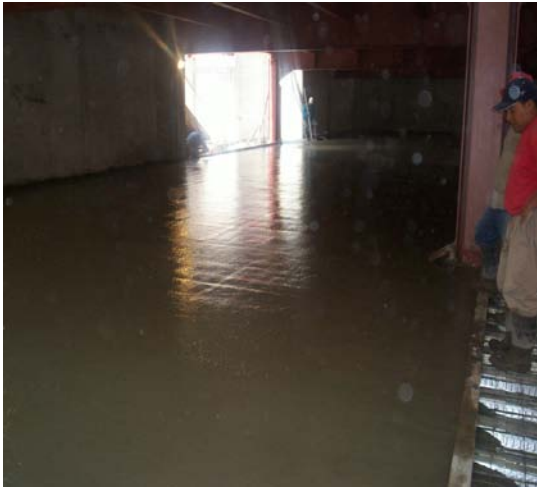
Pulido del piso de concreto.
