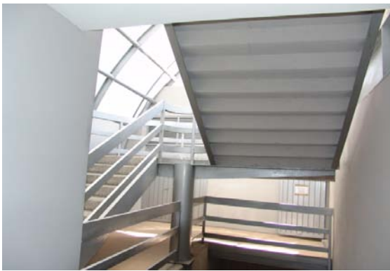
Escalera terminada con la huella y peralte martelinados, barandales y estructura pintados en color gris.
