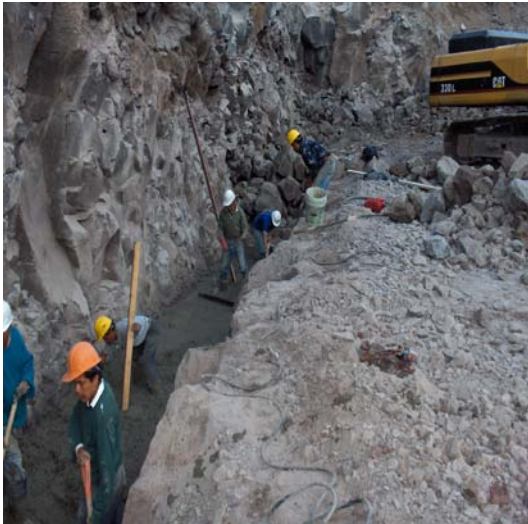
Colado de plantilla niveladora para las zapatas
