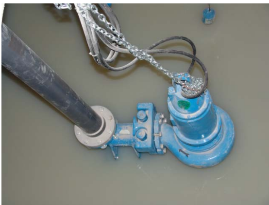
Pruebas de las bombas de aguas negras. La conexión de descarga del cárcamo se realizó al drenaje de toma de productos.
