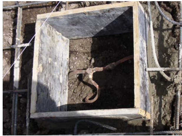
Preparación de cimbra para los registros donde se localiza cada electrodo del sistema de tierras.
