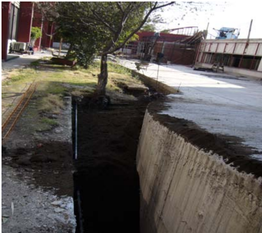
Canalización del cable al site y cuarto de transformadores.
