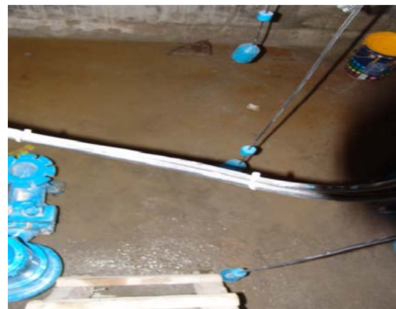
Preparación de las instalaciones, haciendo los pasos para las tuberías de las bombas, instalación de los electroniveles (flotador de nivel) y la conexión de cable eléctrico de uso marino.
