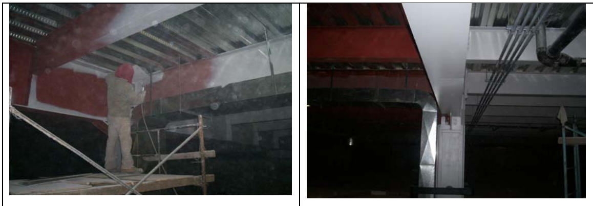
Aplicación de pintura
