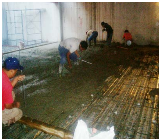
Se verificó el espesor de la capa de concreto con un escantillón.
