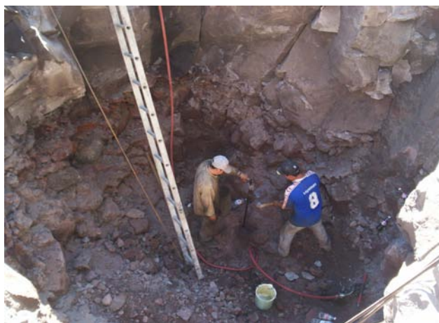
Perforación de cepas de zapatas
