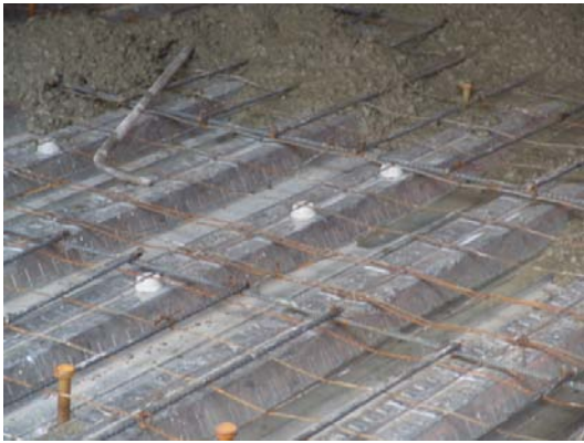
Capa de compresión de losas de entresijo
