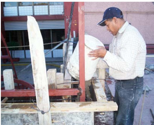
Cimbrado y colado del muro de desplante de la estructura para la cubierta de la escalera metálica ubicada en la entrada a los consultorios y estacionamientos.
