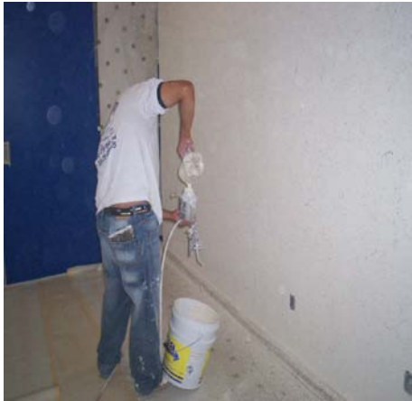
Aplicación de pasta chisa glass como acabado final en todos los muros
