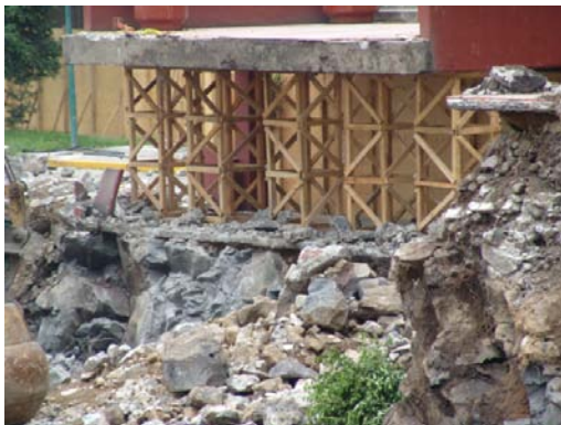
Apuntalamiento de la losa nervada.
