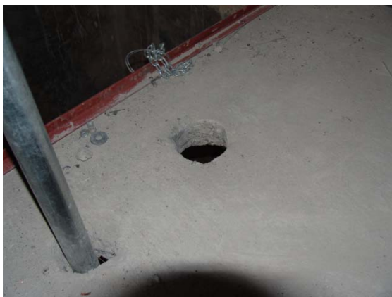
Preparación de las instalaciones, haciendo los pasos para las tuberías de las bombas, instalación de los electroniveles (flotador de nivel) y la conexión de cable eléctrico de uso marino.
