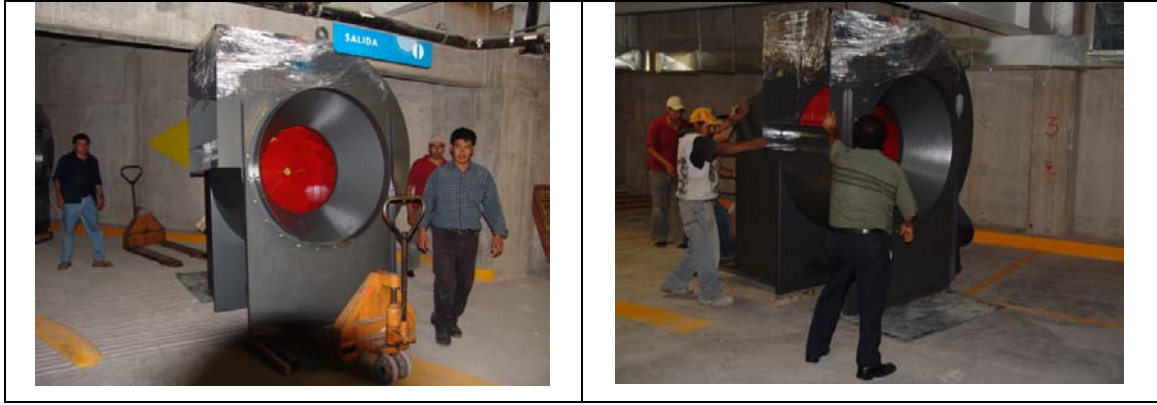
Colocación de ductos de extracción en los sótanos 1 y 2. Así como el acarreo de los extractores axiales.
