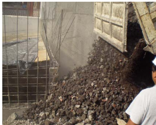
Vaciado de material para relleno.
