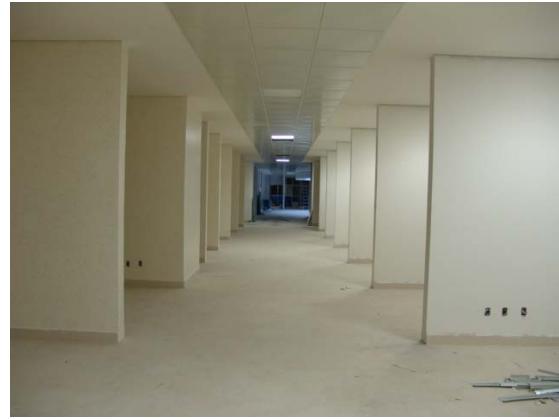
Conclusión de la aplicación de pasta chisa glass en muros y de porcelanato en pisos.
