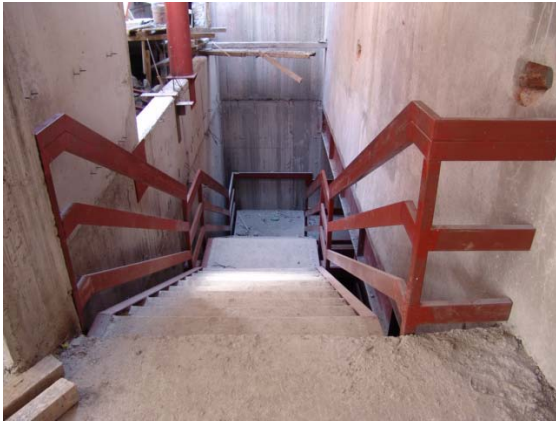
Pasamanos, barandales y estructura de la escalera con primario aplicado,
