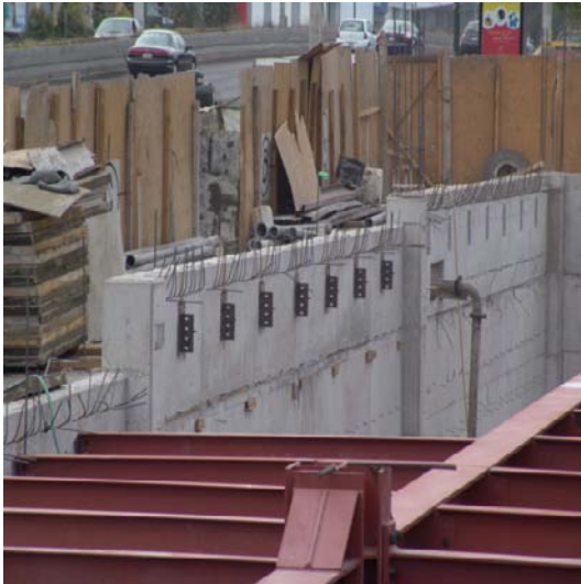
Placas base para la estructura y colocación de malla electrosoldada.
