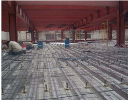
Fijación de lámina deck a estructura con pernos de 3/4" Ø
