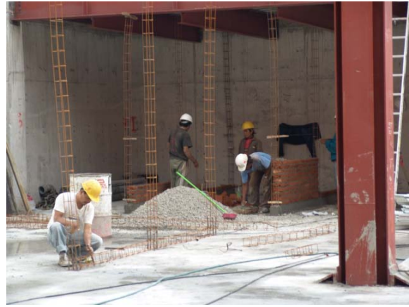
Trazo y desplante de cadenas con muros
