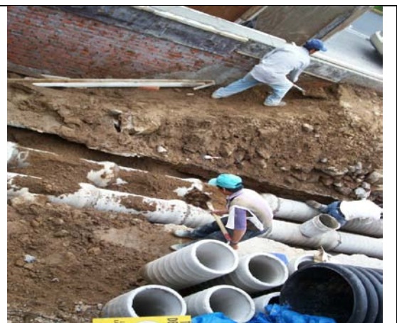
Tendido de tubos de concreto de 30 cms.
