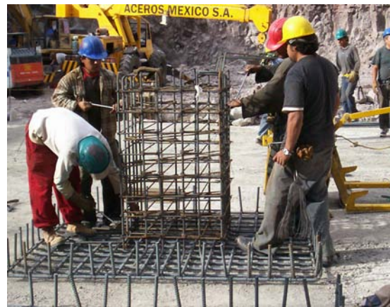
Habilitado de acero de refuerzo
