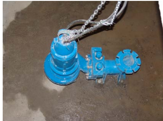
Traslado de las bombas de aguas negras al cárcamo para su instalación.
