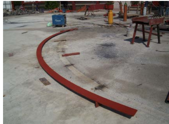
Forjado de alfardas con placa de \frac{1}{2} " de espesor para cubierta de escalera de acceso al nivel de la consulta externa. Así como colocación de placa para recibir la cubierta de la escalera.
