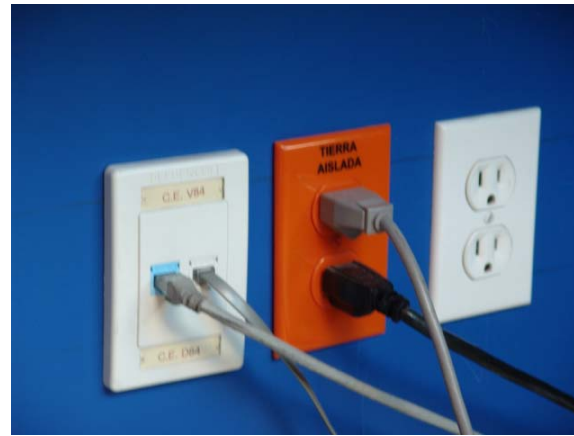
Contactos con energía regulada.
