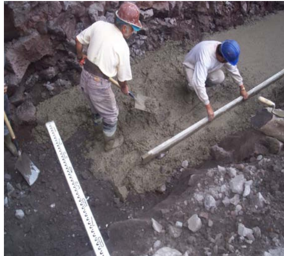
Colado de plantilla niveladora para las zapatas
