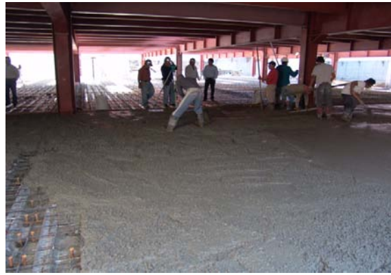
Capa de compresión de losas de entresijo
