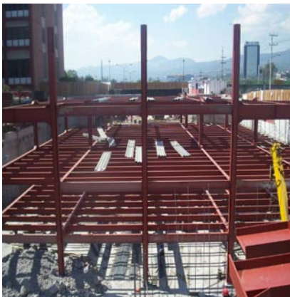
Colocación de estructura y losacero
