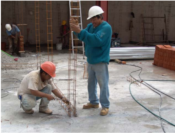
Trazo y desplante de cadenas con muros
