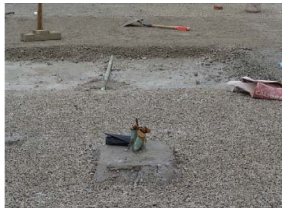
Tepojal con cal para dar pendientes
