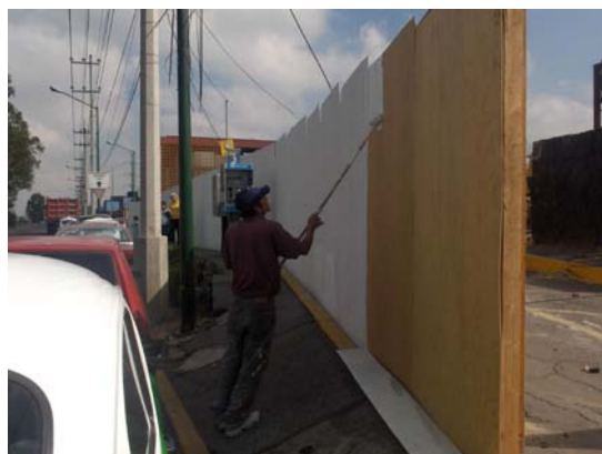
Colocación de tapial de protección perimetral
