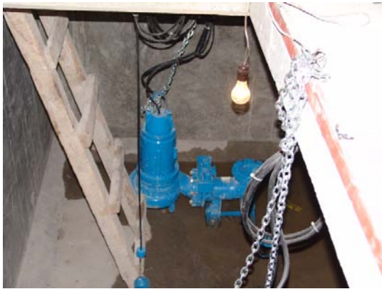
Traslado de las bombas de aguas negras al cárcamo para su instalación.
