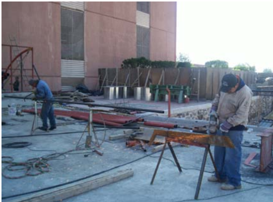
Forjado de alfardas con placa de \frac{1}{2} " de espesor para cubierta de escalera de acceso al nivel de la consulta externa. Así como colocación de placa para recibir la cubierta de la escalera.
