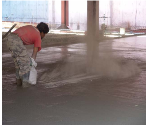
Vaciado de endurecedor sobre el concreto.
