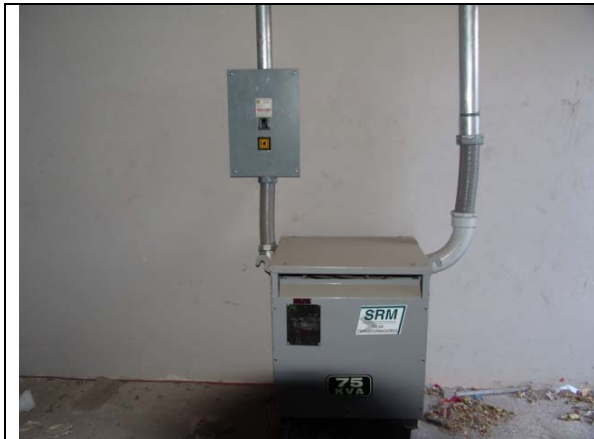
Transformador de 75 KVA conectado a emergencia.
