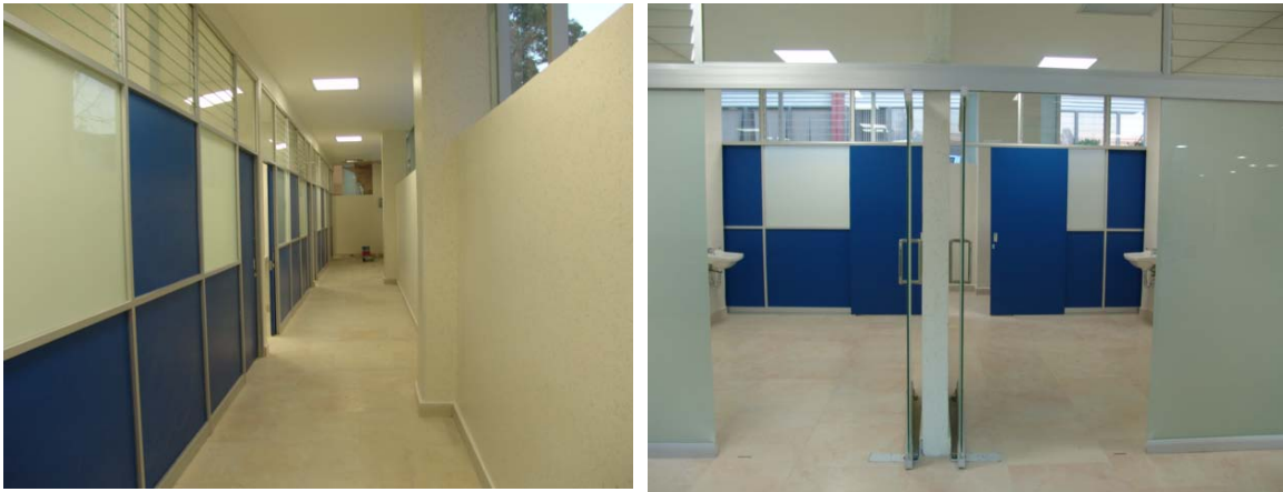
Conclusión de la colocación de piso de porcelanato; cancelaría de aluminio con cristal y tableros de MDF; puertas y divisiones de cristal templado, lámparas ahorradoras de 2 X 32 w.
