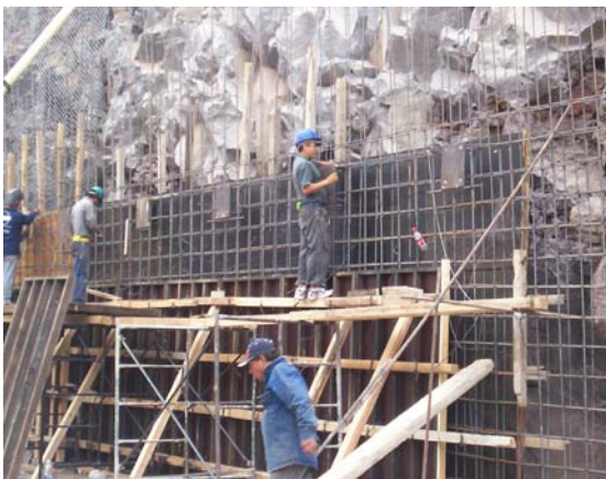
Habilitado de acero de refuerzo
