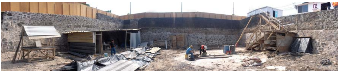
Recimentación del muro perimetral del lado sur.
