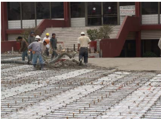
Colado de la capa de compresión
