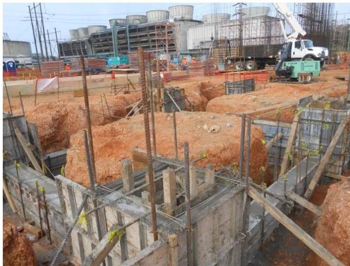
*Imagen 6.2 Colado monolítico de la cimentación para un Rack de Tuberías*
