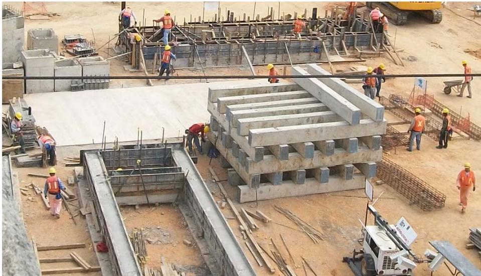
*Imagen 6.6 Construcción de vigas longitudinales*
