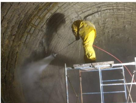
Foto 50: 1ra prueba de limpieza con hidrolavado a una presión de 10,000 psi en muro de túnel a 7.00 m de distancia de la lumbra 8ª
