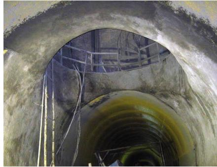
Foto 162 y 163: Conexión entre los tramos L8b-L8a y L8a-L8c, mediante concreto lanzado
