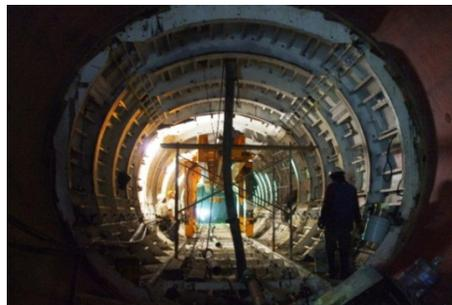
Foto 121: Inyección de Concreto en Clave
