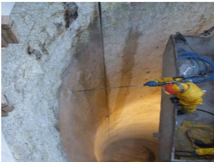
Foto 48: Hidrolavado en muro de Lumbra 8a, 10,000 psi
