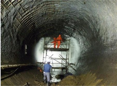
Foto 75: Escarificado en Túnel
