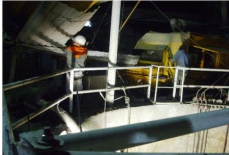
Foto 124: Colocación de Concreto en Bomba de alto alcance
