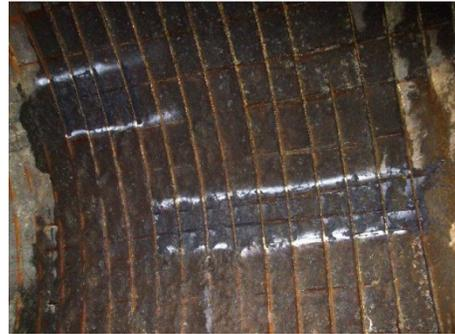
Foto 64 y 65: Recubrimiento con anticorrosivo en acero existente en túnel
