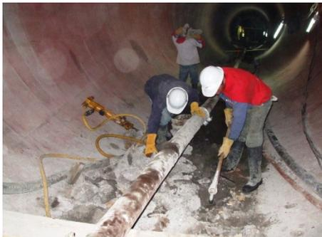
Foto 115: Desensamble de tubería para colado
