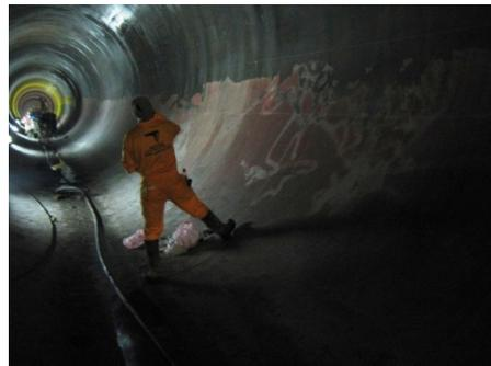
Foto 166y 167: Preparación de superficie para aplicación SYLPYL contra los gases
