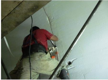
Foto 135: Sellado en junta de T-lock
