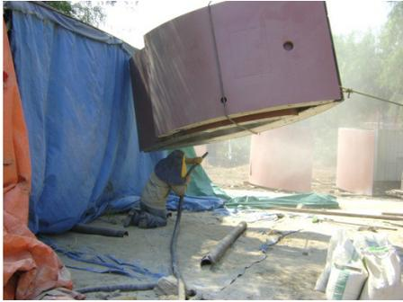
Foto 97: limpieza mediante Sand- Blasteo
