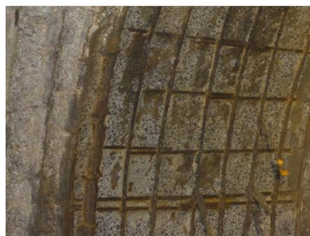
Foto 51: Resultado de la 1er prueba dando resultado de ph3 a ph4
