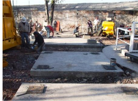
Foto 71: Base para planta de concreto
