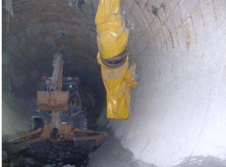
Foto 44: Sistema de Ventilación
