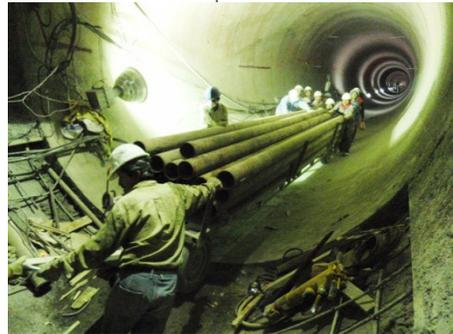
Foto 159: Desmantelamiento de Tubería
