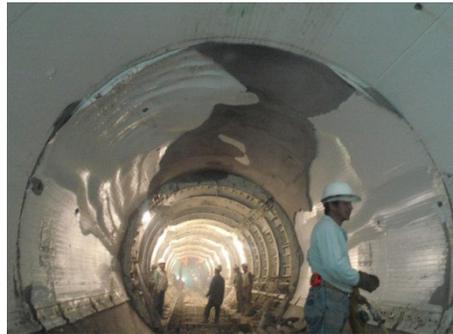
Foto 139 y 140: Filtración de Concreto entre Cimbra y T-Lock
