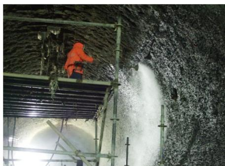
Foto 66: Escarificado en tablas de túnel
