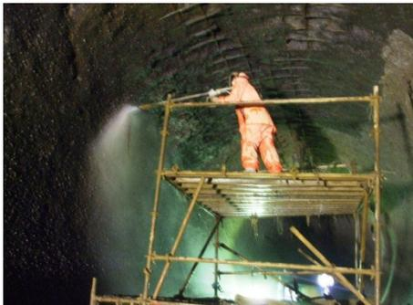
Foto 101: Escarificado en Túnel
