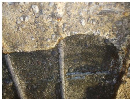
Foto 56: Resultado de la 3ra prueba a 28,000 psi, dejando el acero libre de oxido
