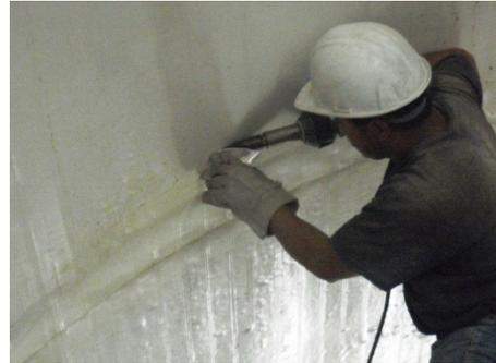
Foto 150: Señado de Juntas de T-Lock
