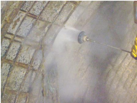
Foto 54: 3ra prueba de escarificado con hidrolavado a una presión de 28,000 psi en muro de túnel a 7.00 m de distancia de la lumbrera 8ª
