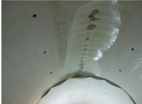
Foto 137 y 138: Filtración de Concreto entre Cimbra y T-Lock
