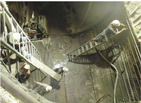
Foto 160 y 161: Conexión entre los tramos L8b-L8a y L8a-L8c, mediante concreto lanzado
