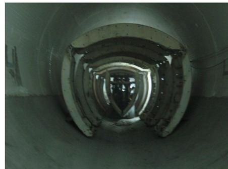
Foto 87 y 88: Desmantelamiento de Cimbra en Túnel
