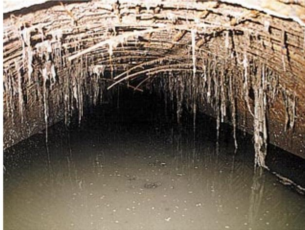
Foto 7: Deterioro en Clave del Drenaje Profundo
