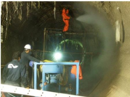
Foto 72: Escarificado en Túnel
