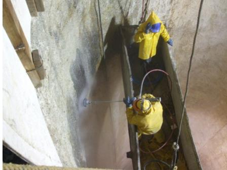
Foto 49: Hidroescarificado en muro de lumbra 8a de 20,000a 25,000 psi
