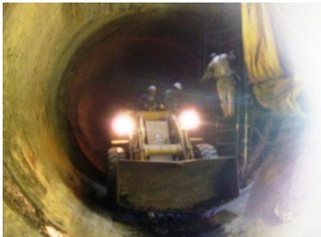
Foto 38: Cargador Frontal utilizado Utilizado para retiro de material
