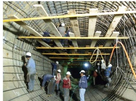
Foto 80: Armado de Acero a 360°
