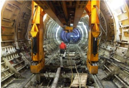
Foto 129: Colocación de tubería para Colado
