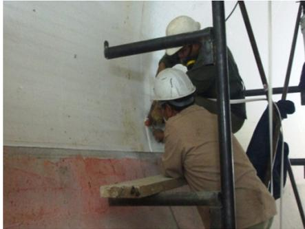
Foto 149: Señado de Juntas de T-Lock
