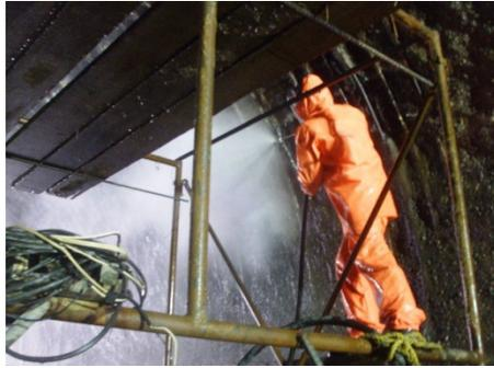
Foto 63: Escarificado en tablas de túnel
