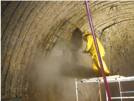
Foto 52: 2da prueba de escarificado con hidrolavado a una presión de 20,000 psi en muro de túnel a 7.00 m de distancia de la lumbrera 8ª
