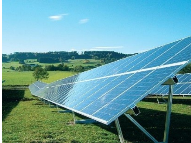
Figura 3.3: Panel fotovoltaico, conformado por módulos fotovoltaicos .
