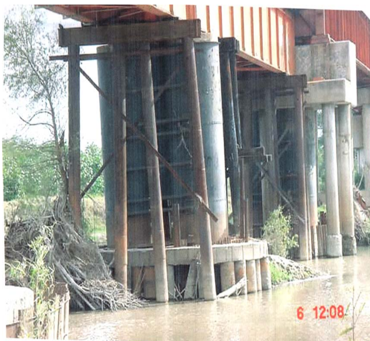
Foto 3 trabajos para reparar la pila numero 12
