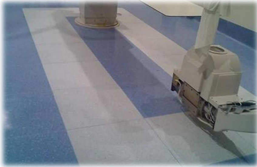
Figura 18. Utilización de Pisos Conductivos en una Sala de Operaciones.
