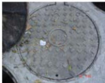
C.4 Las tapas de las cajas de válvulas deben de quedar sobre la válvula, para permitir su operación y mantenimiento.
