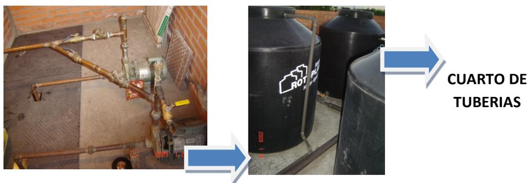
Figura 1.2. Bombeo y descarga a tanques elevados del sistema de distribución.
