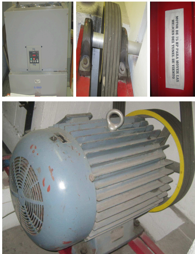
Figura B.4: Sistema para generar el flujo de aire dentro del túnel.
