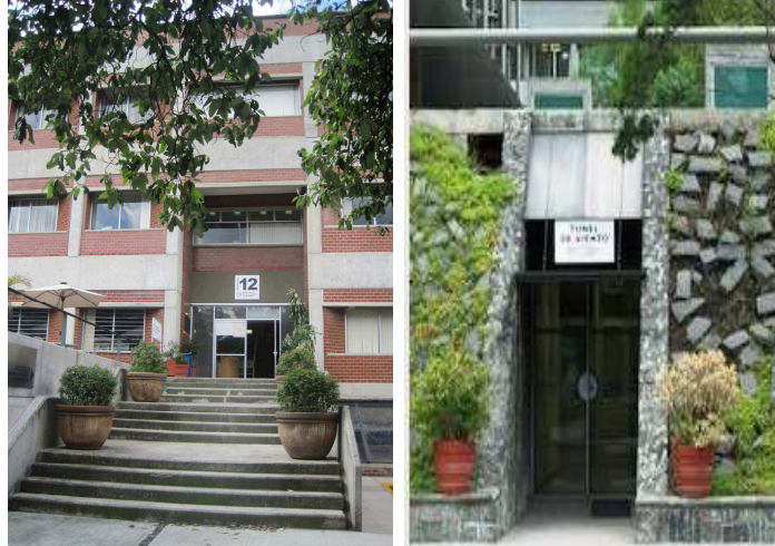
Figura B.2: Instituto de Ingeniería y túnel.
