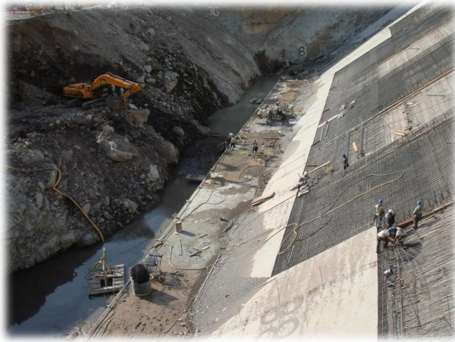
Figura 2.13 Colocación de parrillas de acero de refuerzo
