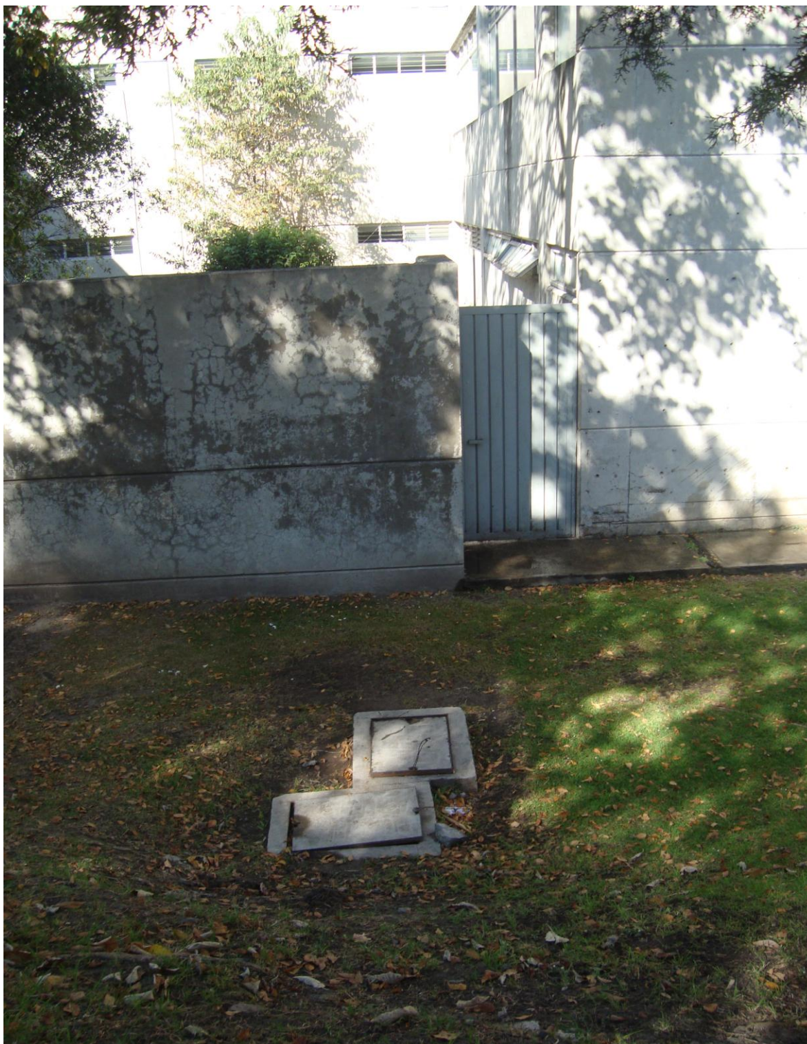
Figura 8.16. Vista de detalle de las estructuras de entrada
