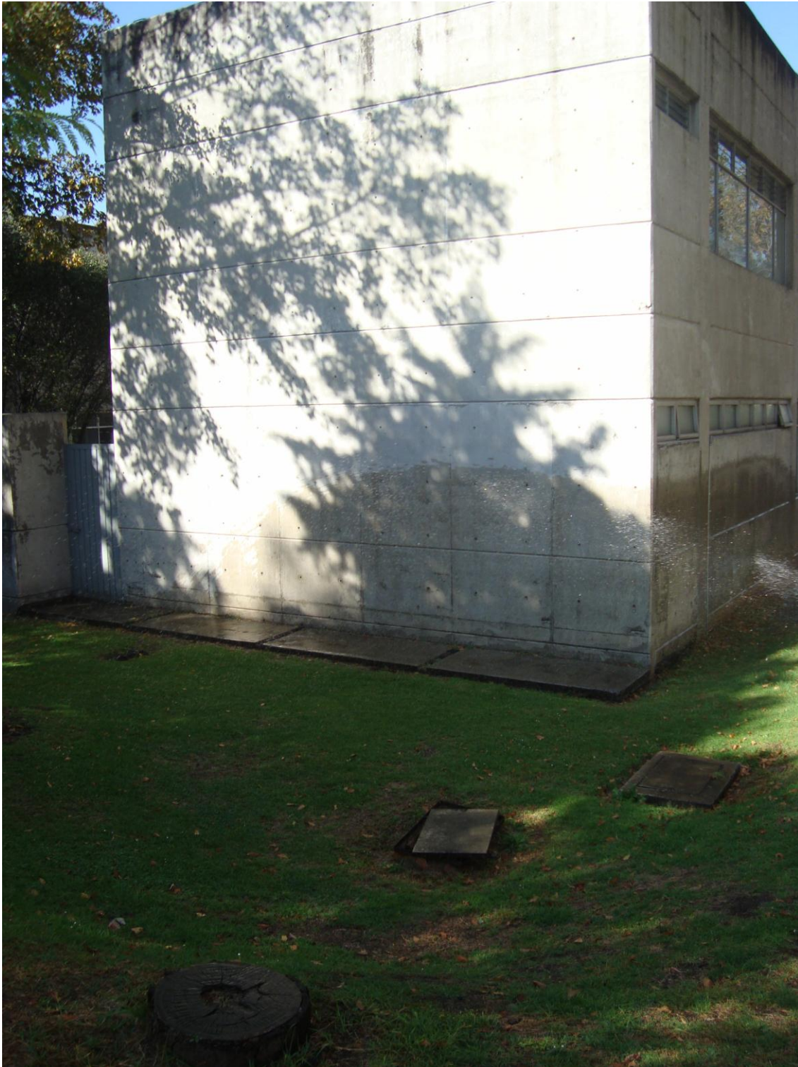
Figura 8.18. Vista panorámica de las estructuras de salida
