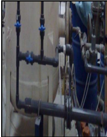
Fig.2.12 Circuito en paralelo de inyección de gas.
