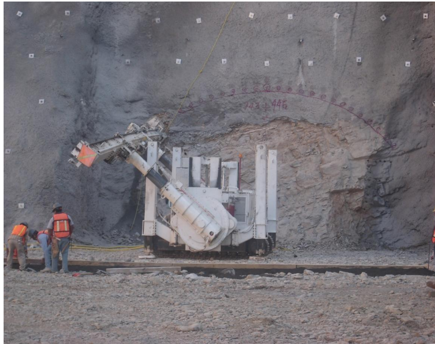
Imagen 15. Ejecución del enfilaje.
