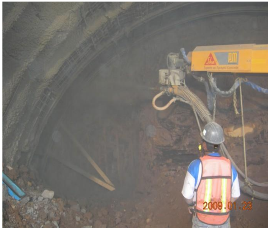
Imagen 14 .Concreto lanzado en portal.
