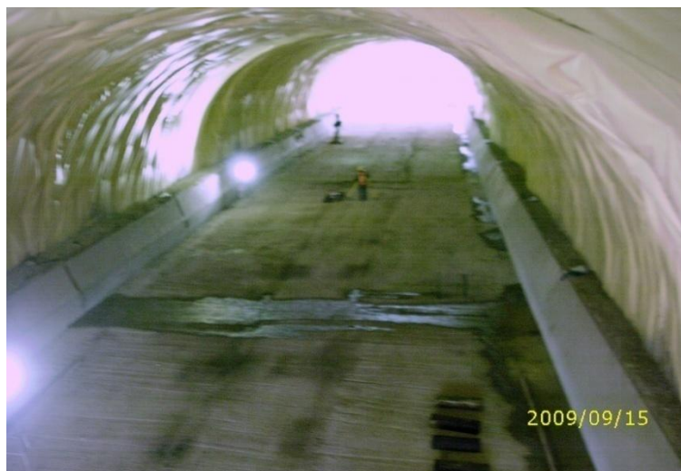
Imagen 20. Vista panorámica del túnel terminado.
