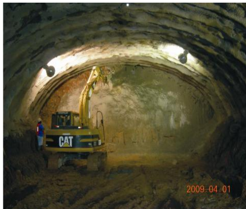
Imagen 11 .Excavación en la galería derecha
