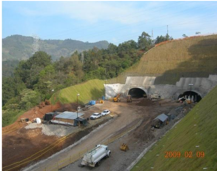
Imagen 19. Aspecto general del túnel Huauchinango.
