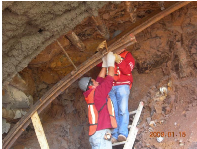
Imagen 12 .Colocación de marco metálico.
