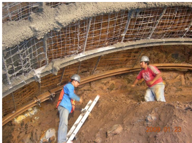
Imagen 13 .Colocación de malla electrosoldada
