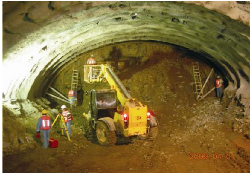
Imagen10 .Excavación en la galería izquierda
