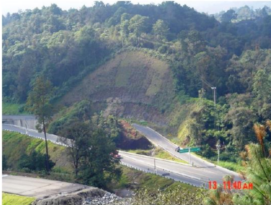
Fotografía 3. Detalle de excavaciones en corte abierto en la zona en materiales similares a los del portal de entrada México – Túneles Huachinango.
