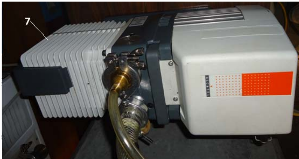
Figura 35. Bomba de vacío
