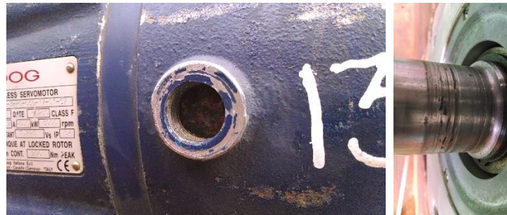
42. Chaqueta de enfriamiento y daño en lado carga (flecha).
