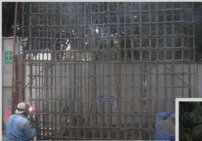
FIGURA NO. 30 Soldadura en traslape de armado.
