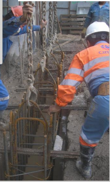
FIGURA NO. 32 Colocación de armado
