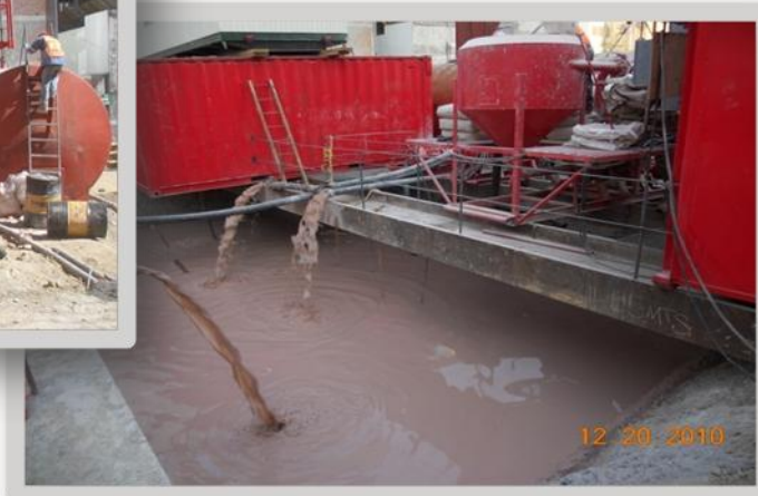
FIGURA NO. 14 Desarenado de muro pantalla
