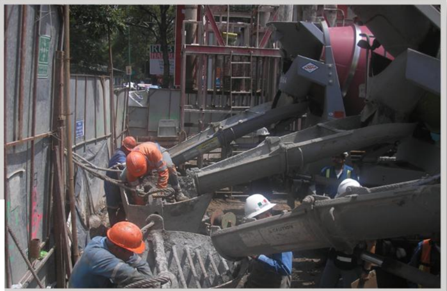
FIGURA NO. 36 Colocación de embudos
