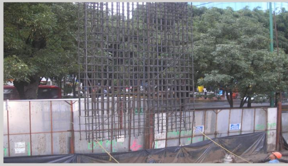
FIGURA NO. 25 Izaje de armado
