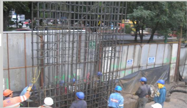
FIGURA NO. 29 Traslape de armado
