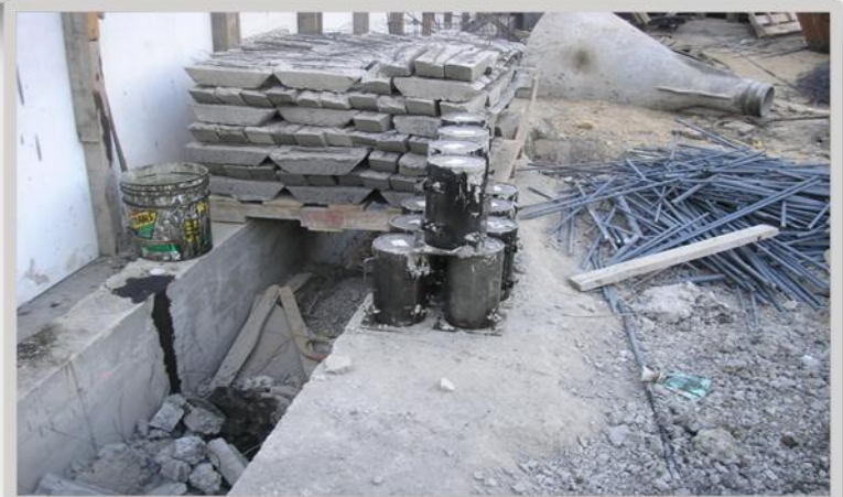
FIGURA NO. 46 Cilindros de concreto
