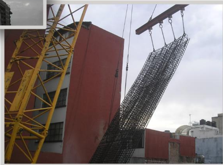
FIGURA NO. 24 Izaje de armado
