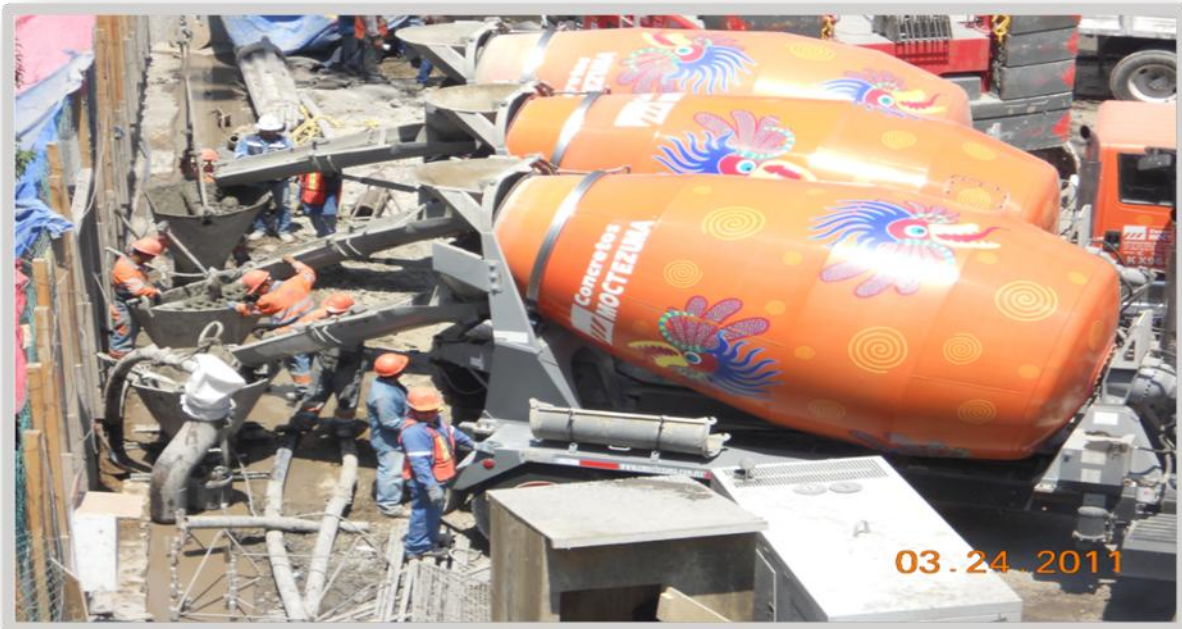
FIGURA NO. 39 Colado de panel
