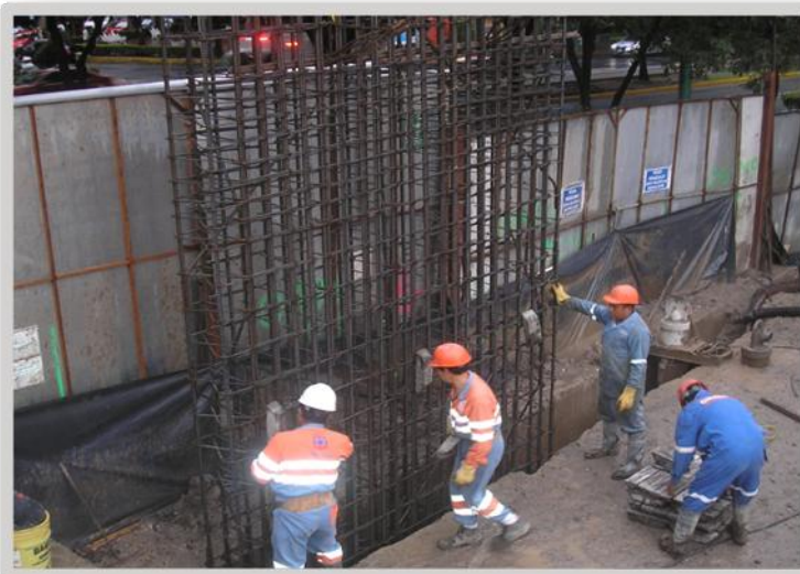
FIGURA NO. 26 Izaje de armado
