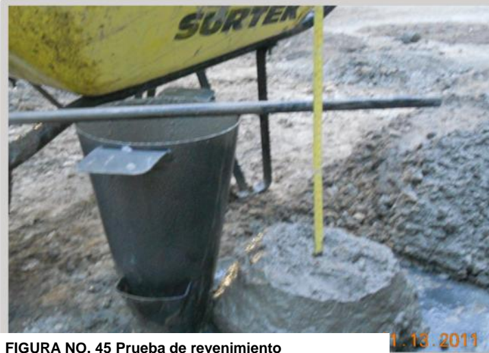
FIGURA NO. 45 Prueba de revenimiento
