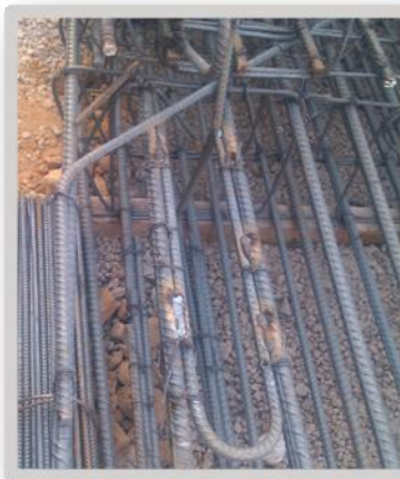
FIGURA NO. 44 Soldadura en asas
