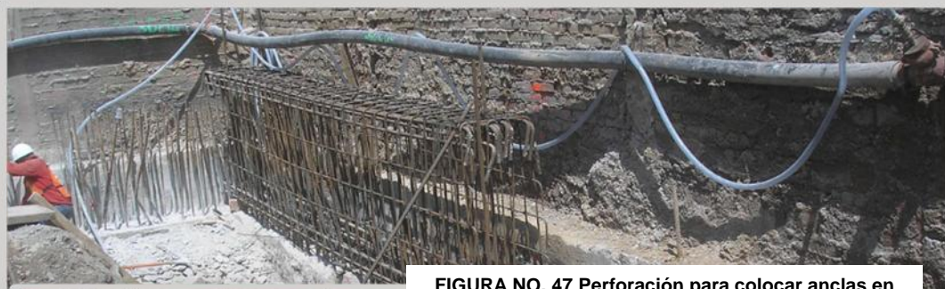
FIGURA NO. 47 Perforación para colocar anclas en muro pantalla
