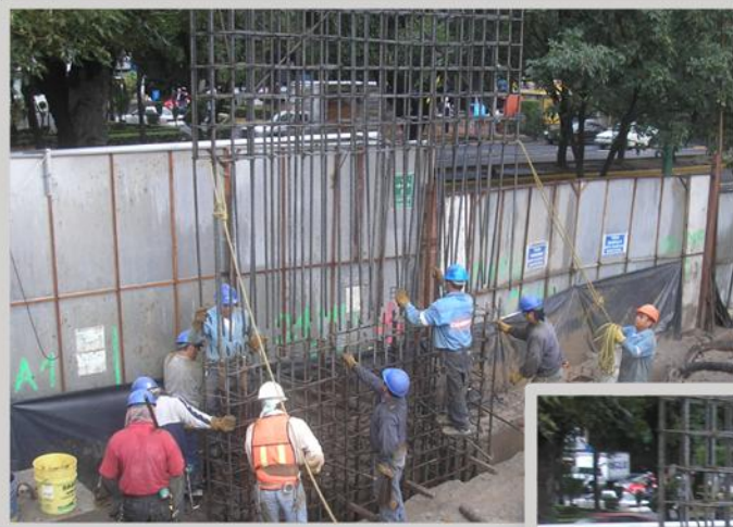
FIGURA NO. 28 Traslape de armado
