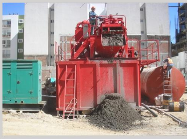
FIGURA NO. 13 Desarenado de muro pantalla
