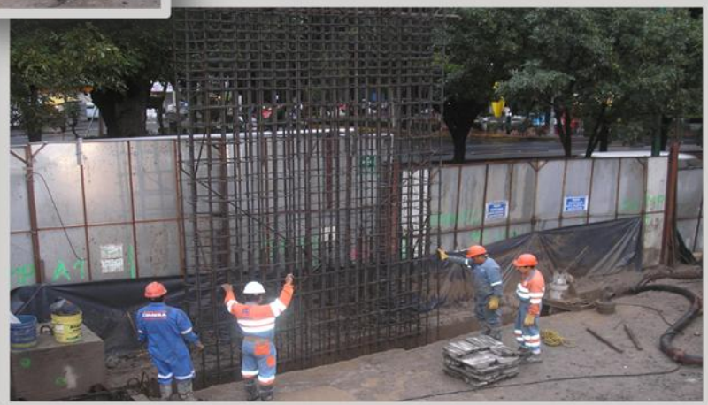
FIGURA NO. 27 Izaje de armado
