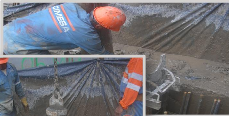
FIGURA NO. 33 Posición final de armado
