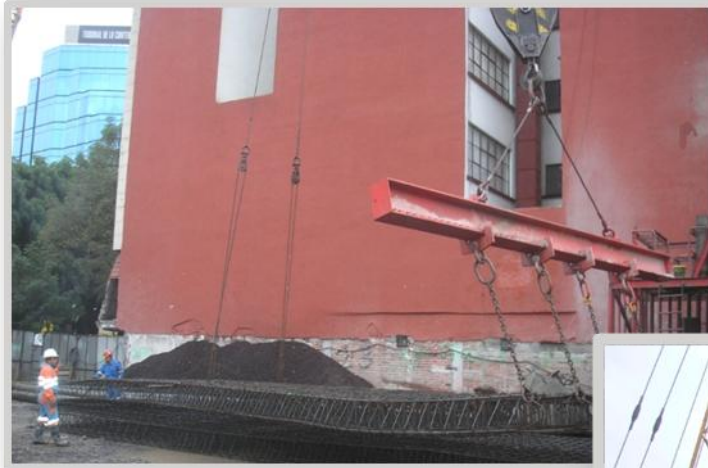
FIGURA NO. 22 Izaje de armado
