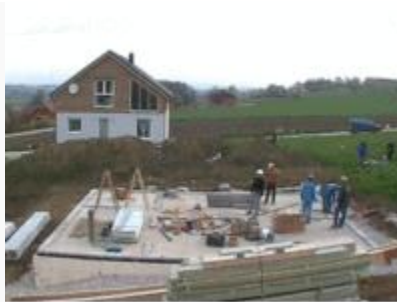
Construcción de una casa prefabricada modular.
