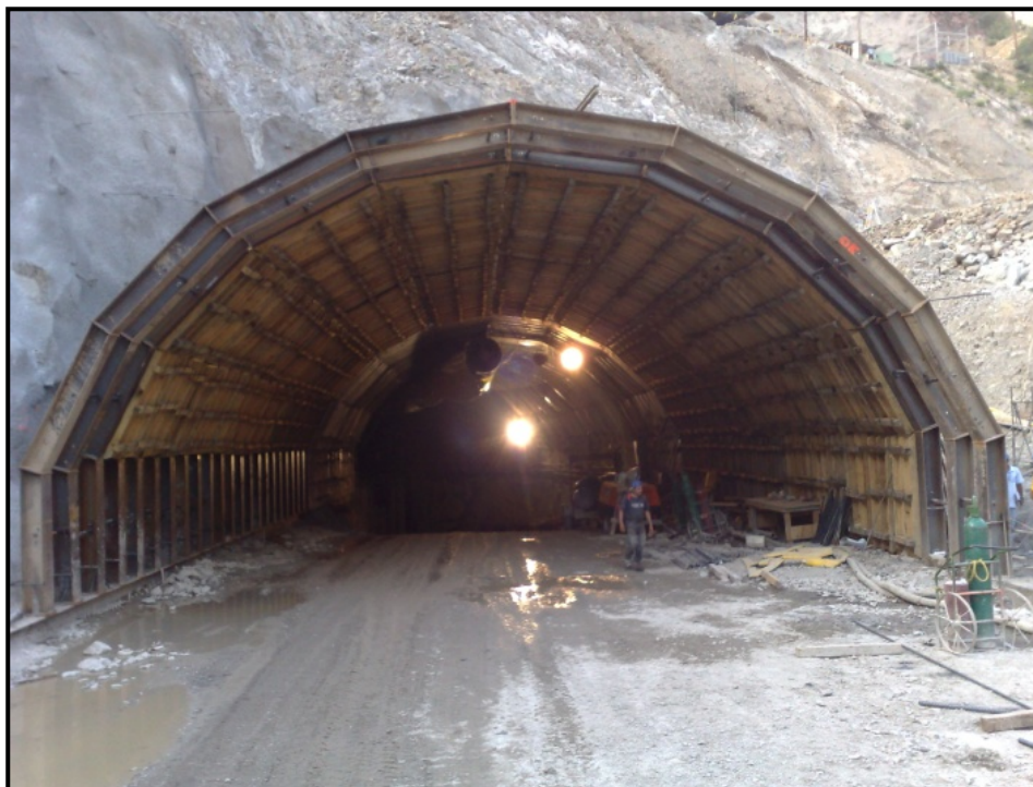
Figura 7.26 Cimbrado con marcos metálicos
