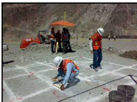
Figura 4.20 Equipo de topografía preparando la zona de instrumentación
