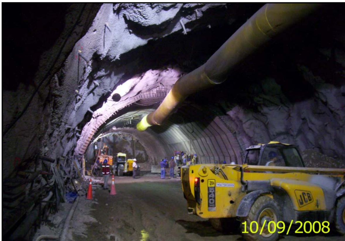
Figura 7.13 Trabajos de perforación y voladura en el frente de excavación II
