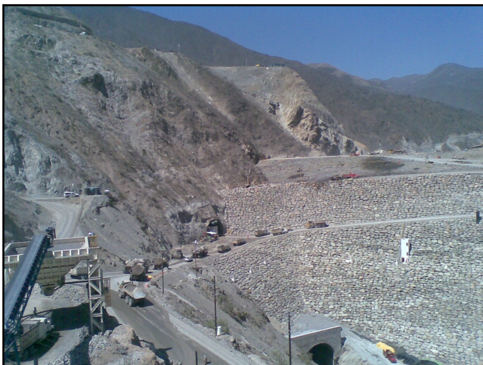
Figura 7.31 Camiones cargados transitando sobre el túnel falso.
