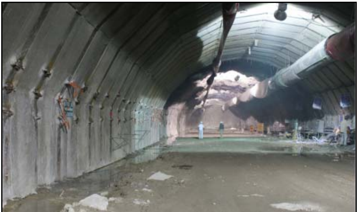
Figura 7.17 Media sección superior concluida Etapa I
