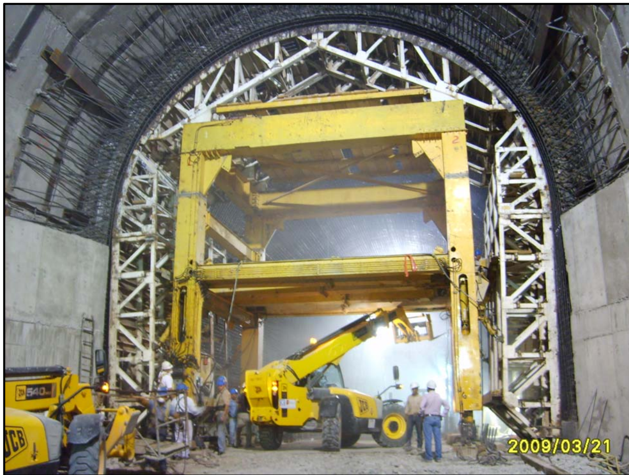
Figura 7.24 Cimbra deslizante para el revestimiento secundario del túnel de desvió
