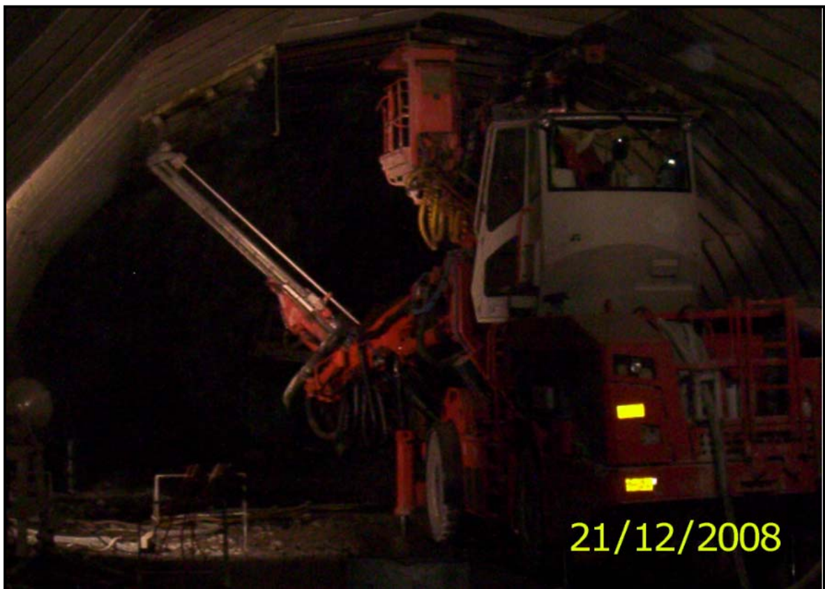
Figura 7.15 Jumbo de tres brazos perforando barrenos
