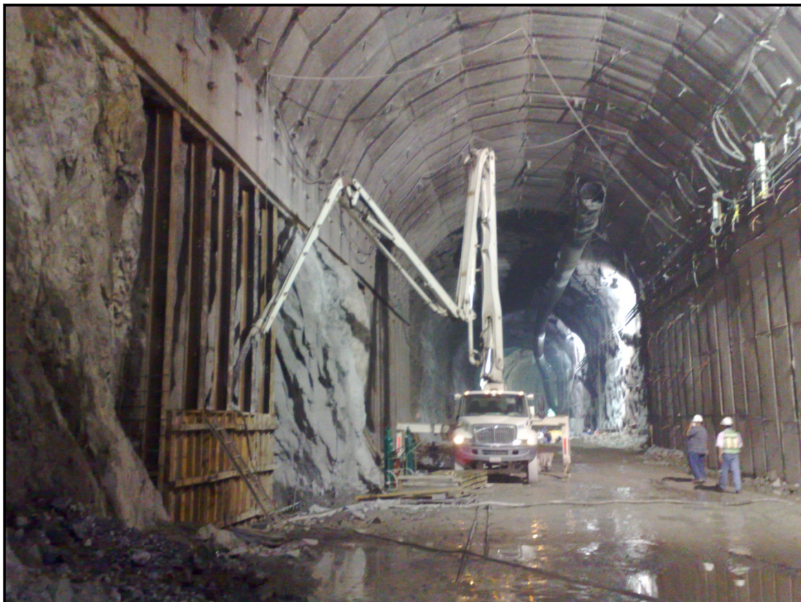
Figura 7.21 Colocacion de concreto en hastial derecho de la media sección inferior
