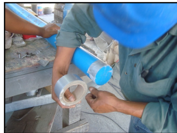
D. Se coloca cinta para ductos una vez realizado el paso anterior
