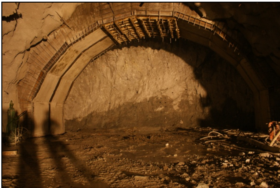
Figura 7.12 Trabajos de perforación y voladura en el frente de excavación I
