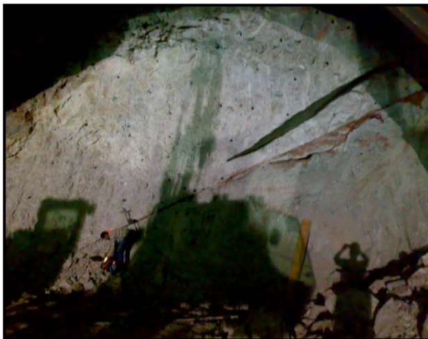
Figura 4.23 Falla interceptada en Túnel de Desvió
