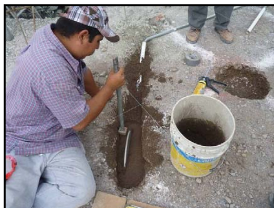
B. Relleno y compactación alrededor de la célula de presión
