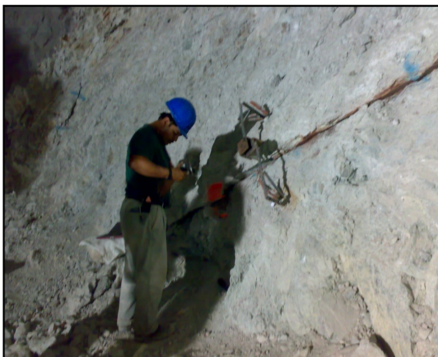
Figura 4.25 Instalación de medidor de juntas tridimensionales en túnel
