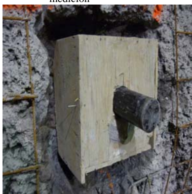
H) Colocación de cimbra
