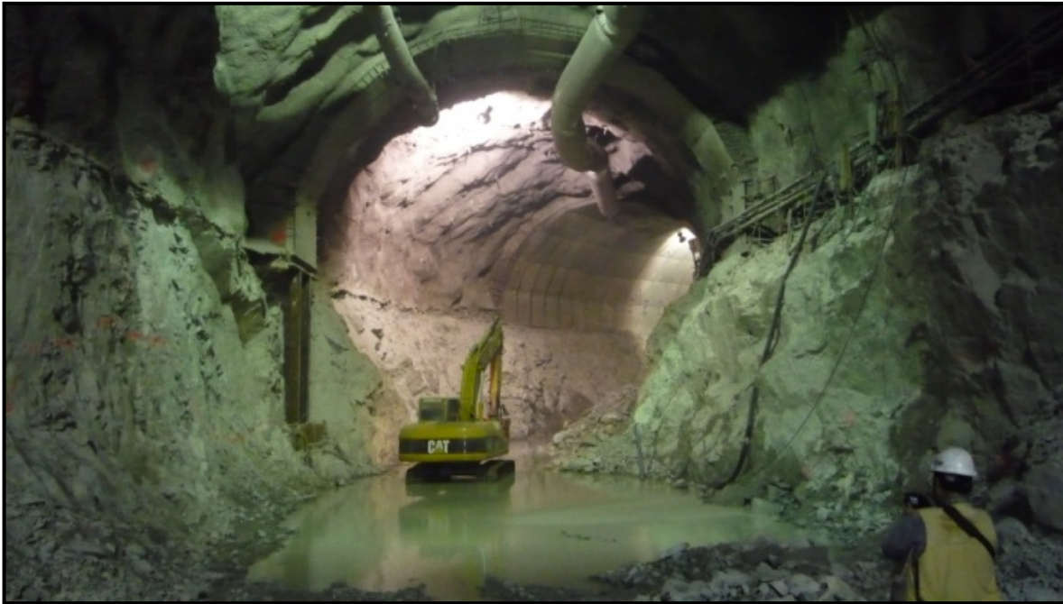
Figura 7.18 Excavación de la media sección inferior
