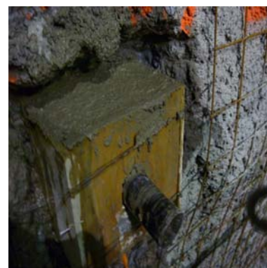
I) Colado del dado de protección
