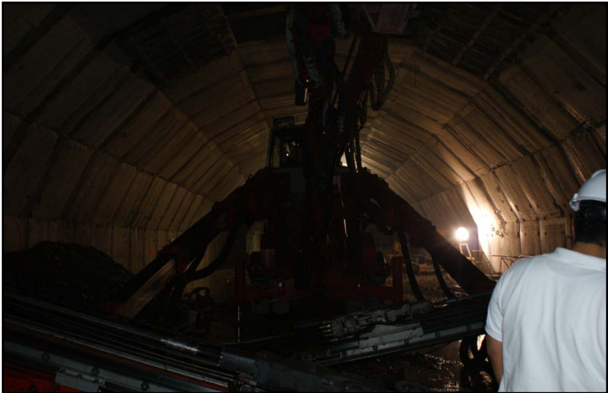
Figura 7.14 Jumbo de tres brazos realizando perforaciones para anclas de esquina
