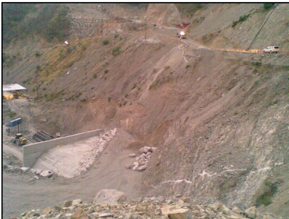
Figura 7.28 Colocación de relleno sobre el Túnel Falso
