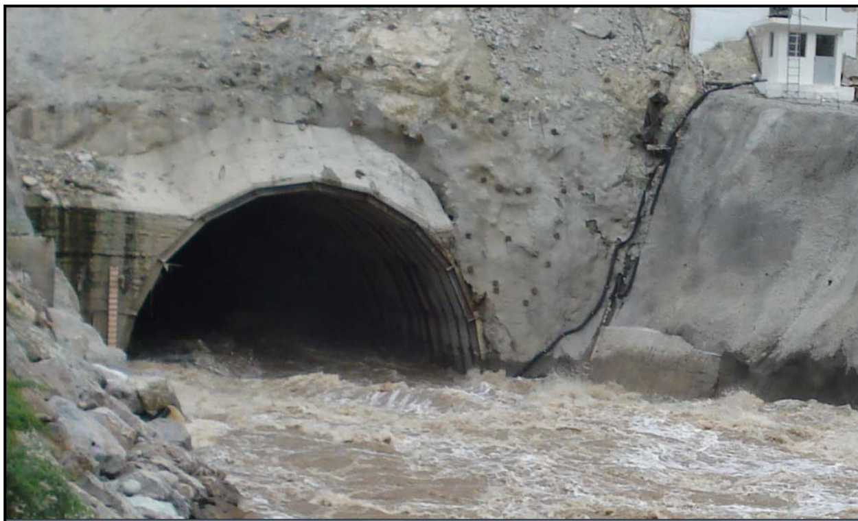
Figura 4.26 Instrumentación a la salida del Túnel de Desvío I
