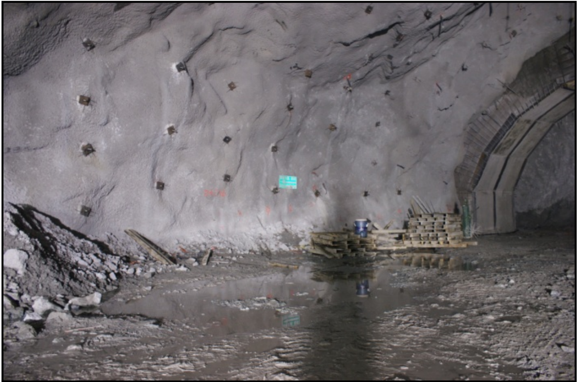
Figura 7.16 Patrón de anclaje y concreto lanzado en zona sin marcos metálicos.
