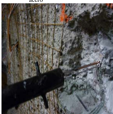
E) Colocación del cabezal de medición
