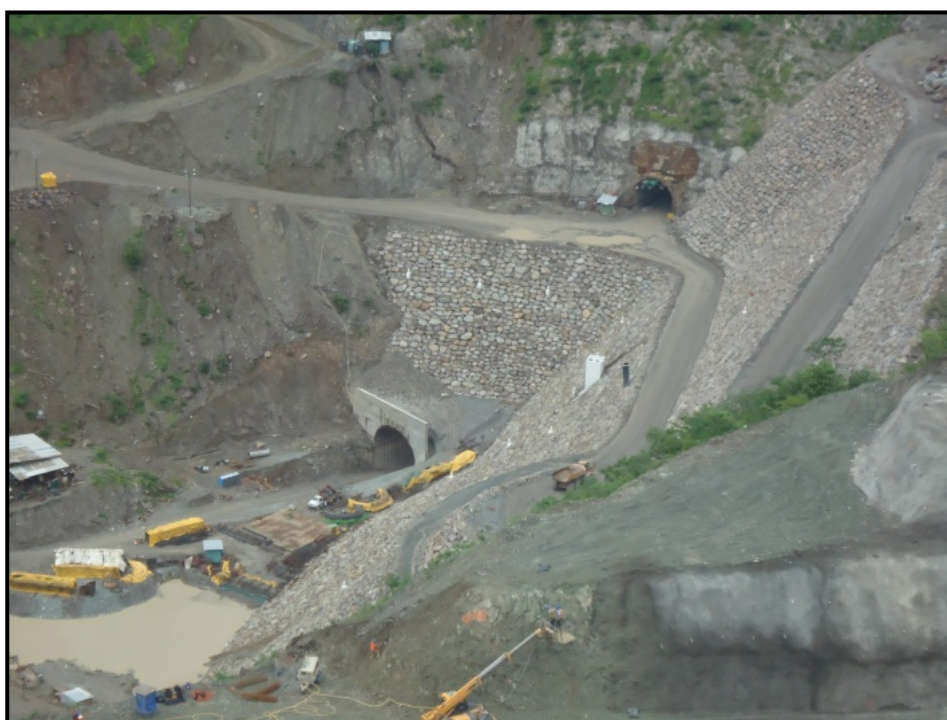
Figura 7.29 Berma y talud del camino concluidos
