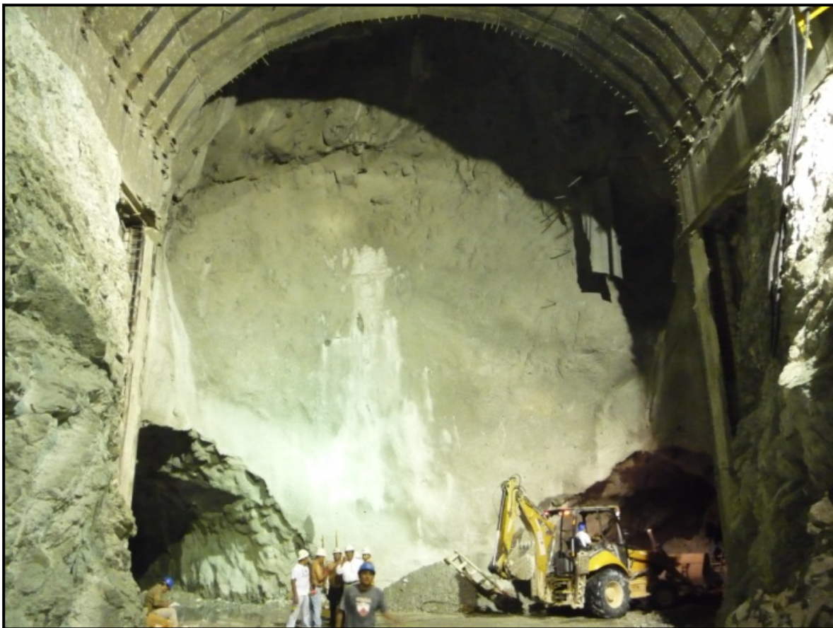
Figura 7.19 Excavación de la media sección inferior en intersección con galería de oscilación
