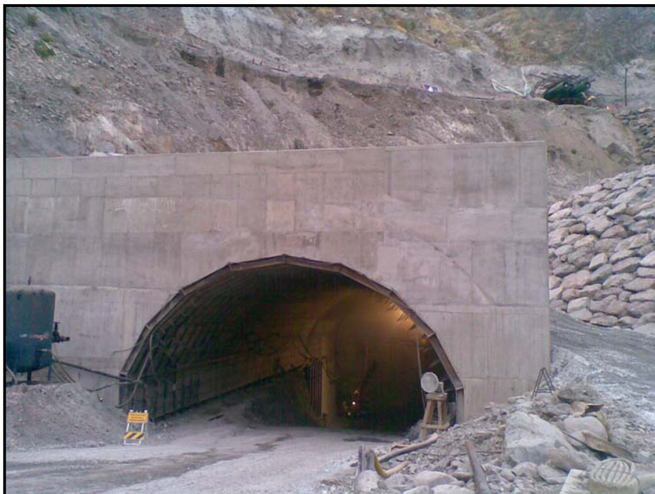
Figura 7.30 Colocación de la media sección inferior.
