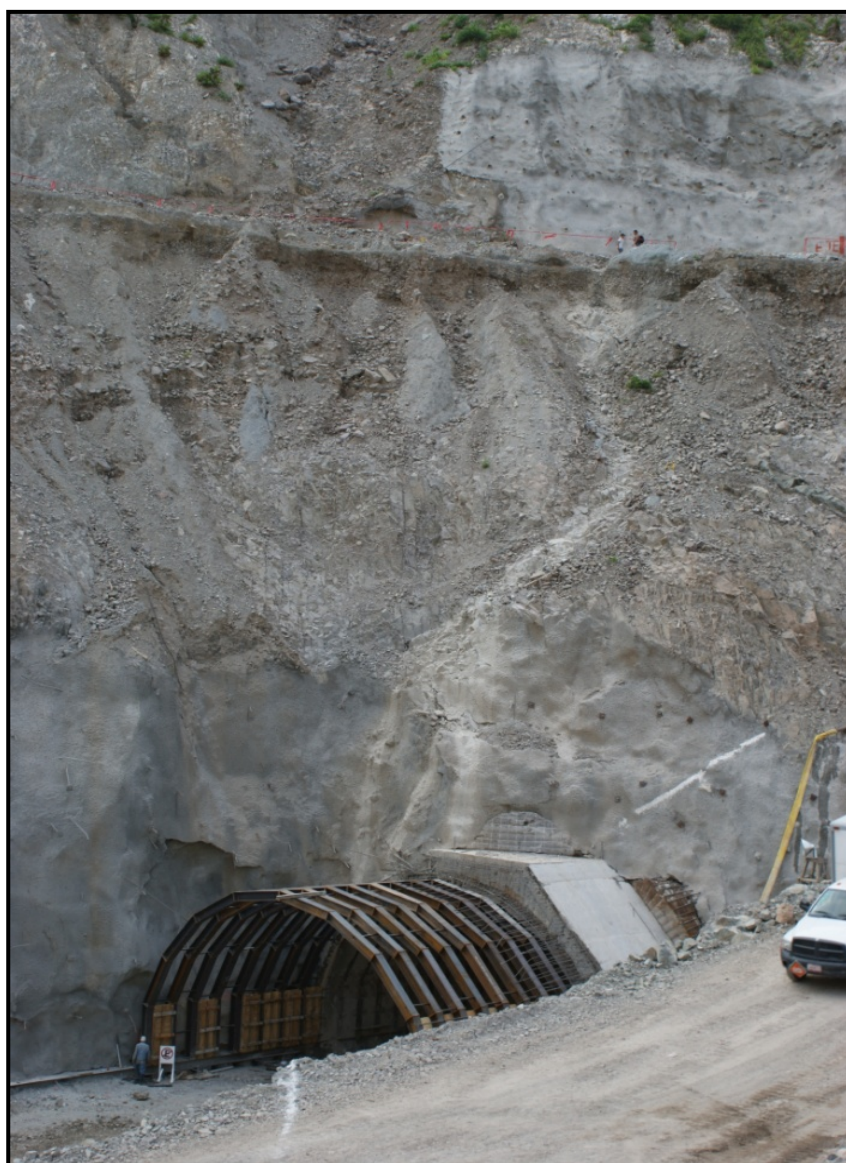
Figura 7.25 Colocación de Marcos Metálico del túnel falso
