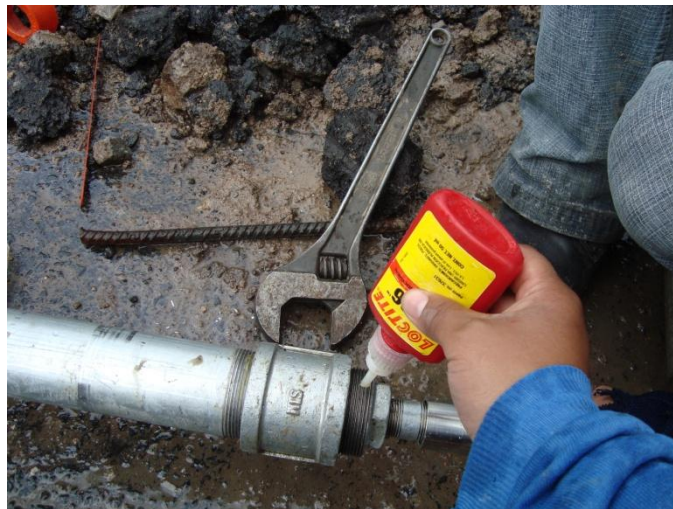
Figura 83. Habilitado de la tubería para Piezo-celda.
