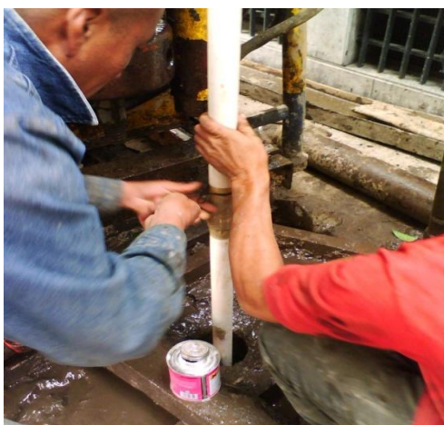
Figura 76. Acoplamiento de tubería para piezómetro.
