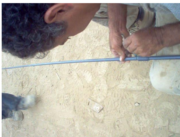
Figura 65. Colocación de recubrimiento en barras de acero inoxidable.
