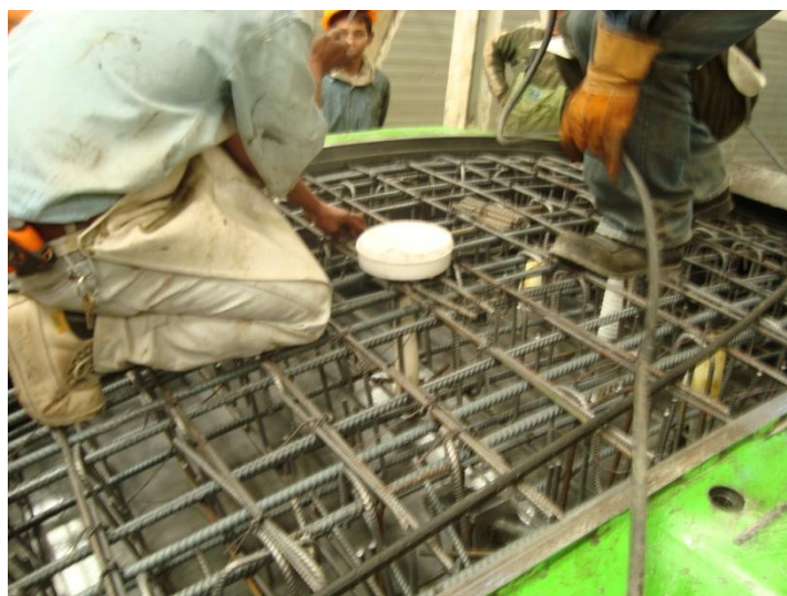
Figura 39. Habilitado de insertos en dovela.
