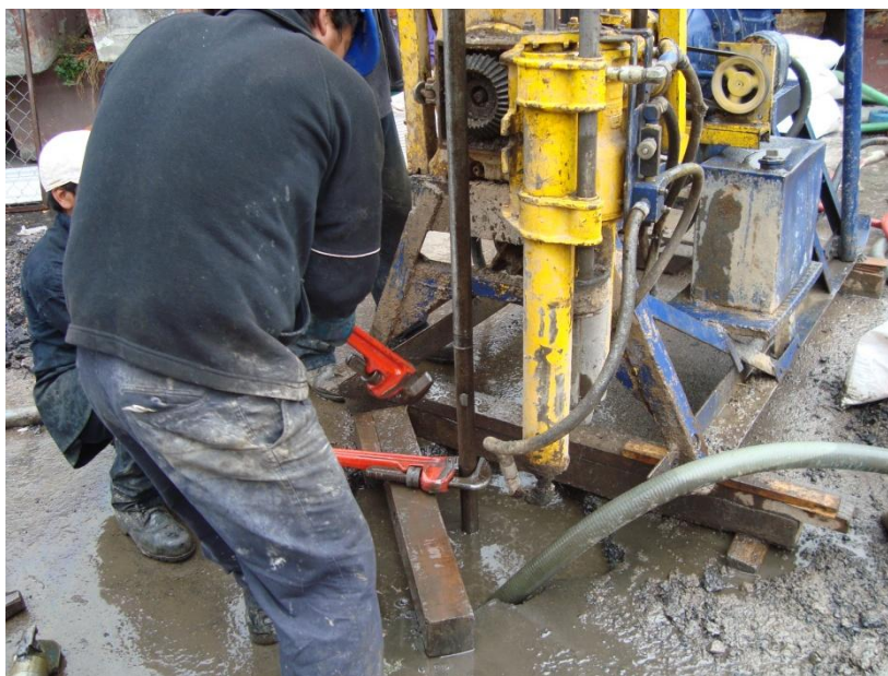
Figura 61. Perforación de barreno para instalación de inclinómetro.
