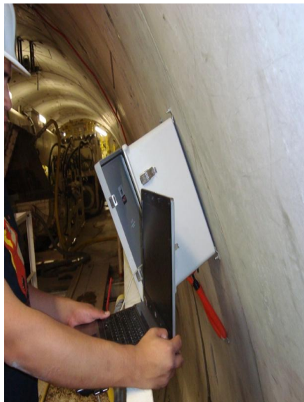
Figura 58. Programación de sistema de convergencia y divergencia.
