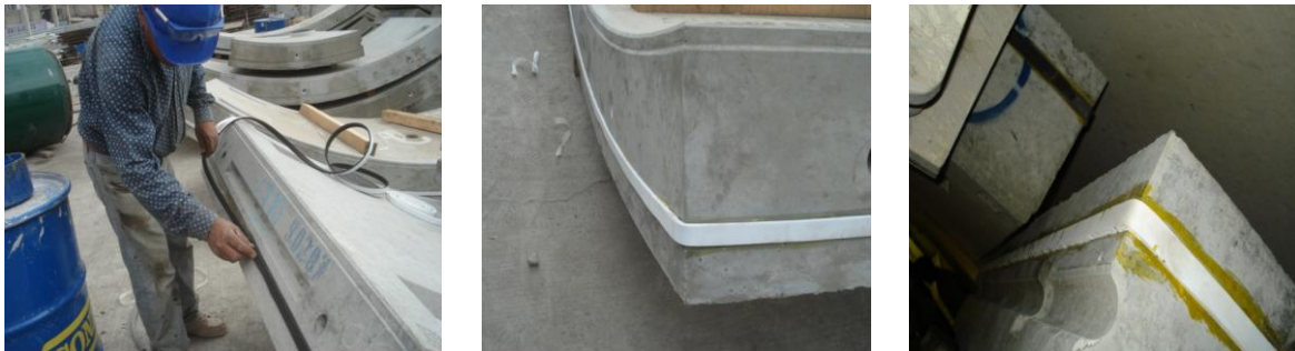
Figura 7. Colocación de sellos en dovelas.
