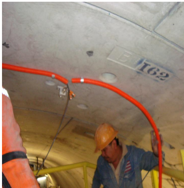
Figura 56. Colocación de cables de comunicación entre clinómetros.
