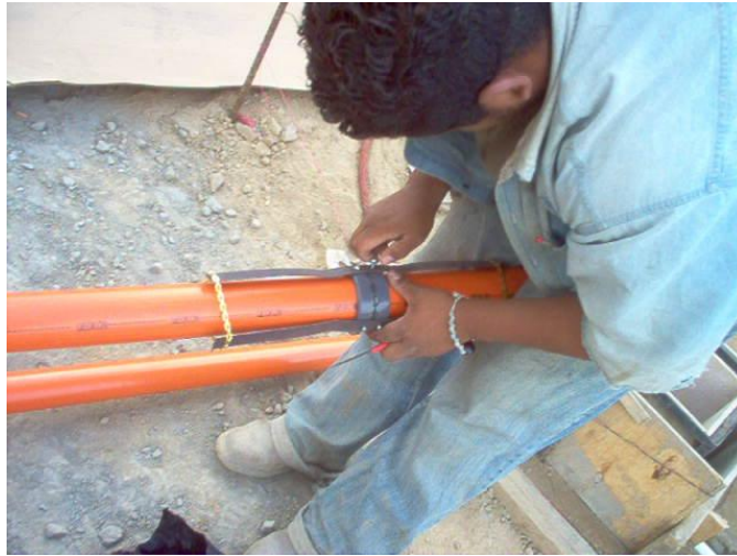
Figura 72. Colocación de arañas magnéticas.
