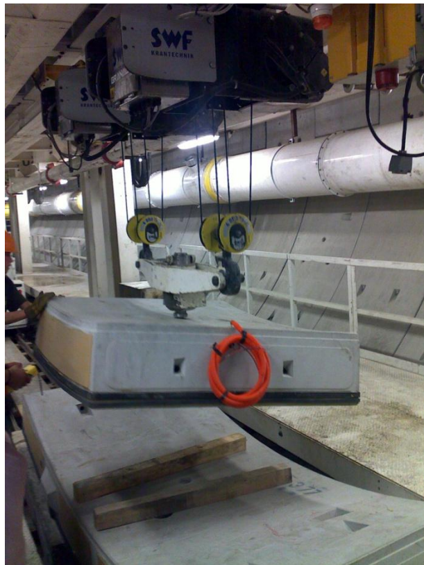
Figura 41. Maniobra de transportación de dovela instrumentada.
