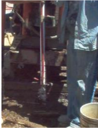
Figura 79. Piezómetro de cuerda vibrante, antes de ser lastrado.
