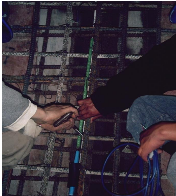
Figura 44. Instalación en el acero de refuerzo de un deformimetro de acero.
