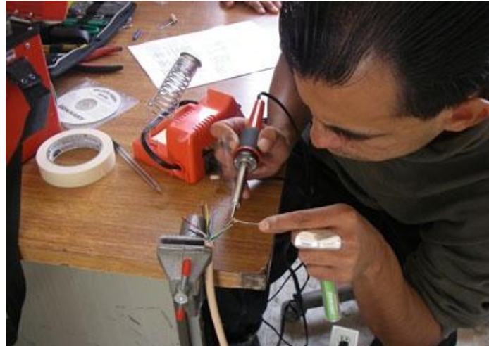
Figura 49. Empalme de los cables de cuatro hilos con el cable 8023-5 de 10 hilos.
