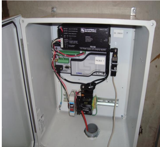
Figura 57. Vista interior de Datalogger.
