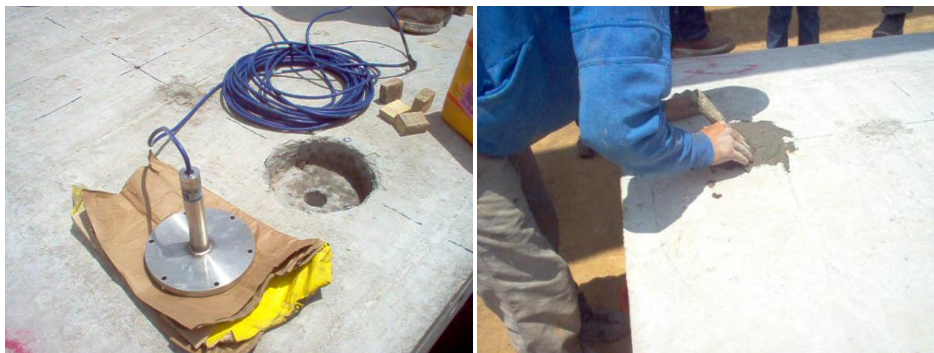
Figura 40. Colocación y fijación de celdas en dovela.
