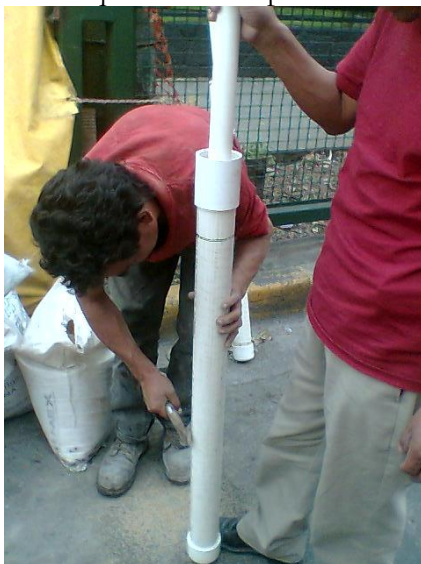
Figura 75. Preparación de bulbo para piezómetro abierto.
