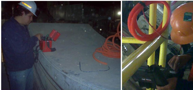
Figura 42. Toma de lecturas de celda de presión de tierra.
