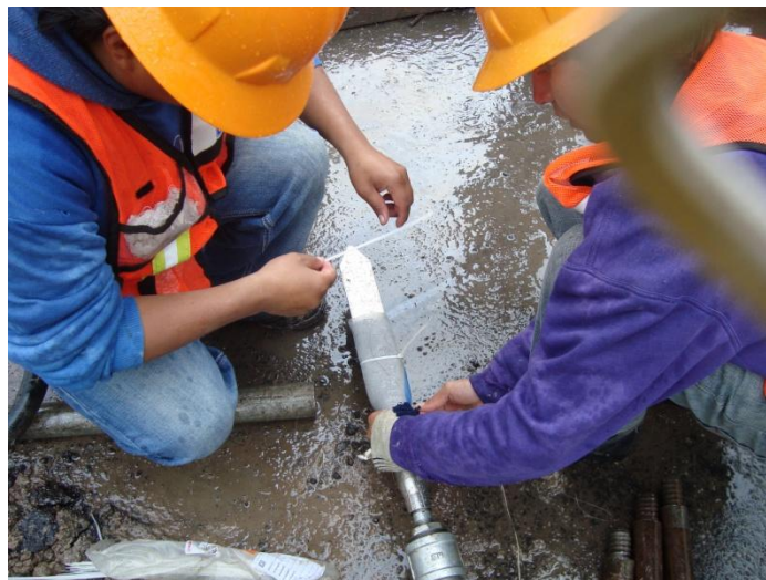
Figura 82. Filtro de geomalla en celda porosa.
