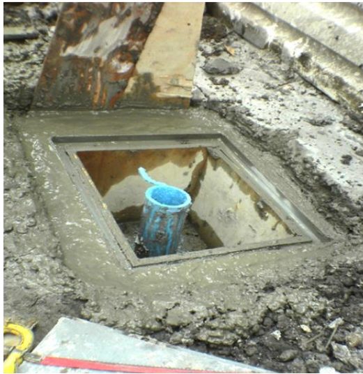
Figura 63. Registro de Inclinómetro.
