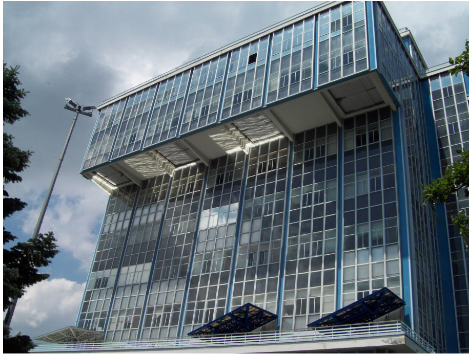
Figura A-5: Fachada sur del laboratorio mostrando los heliostatos para los concentradores de disco de 1.5 y 2 m de diámetro.
