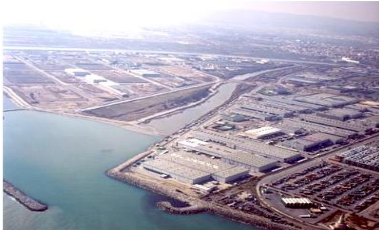
Fig 2.11 Vista aérea de la ZAL (Fuente: http://www.zal.es )
