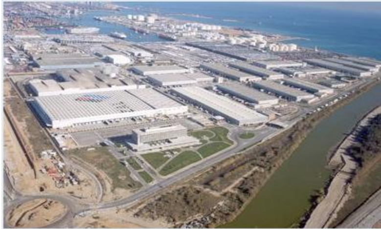
Fig 2.10 Vista aérea desde el lado del Rió Llobregat (Fuente: http://www.zal.es )
