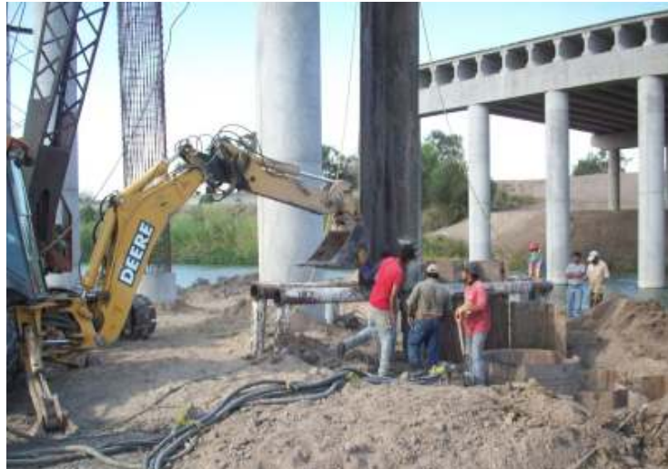
Incrustación de tablestaca
