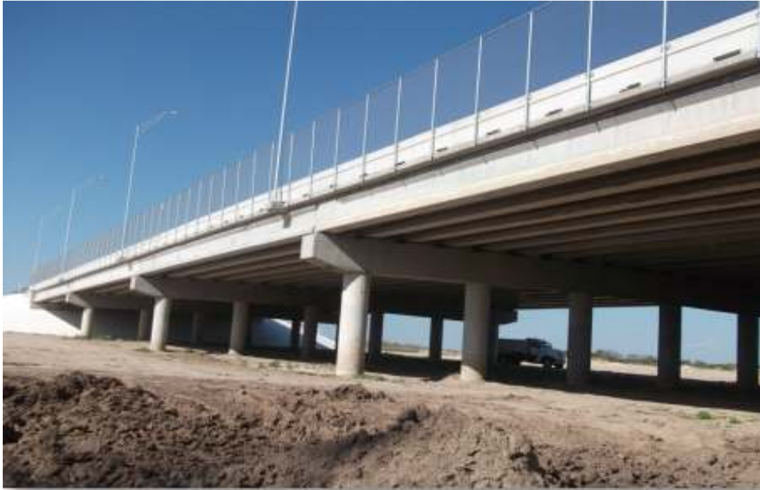
VISTA LATERAL DEL PUENTE TERMINADO
