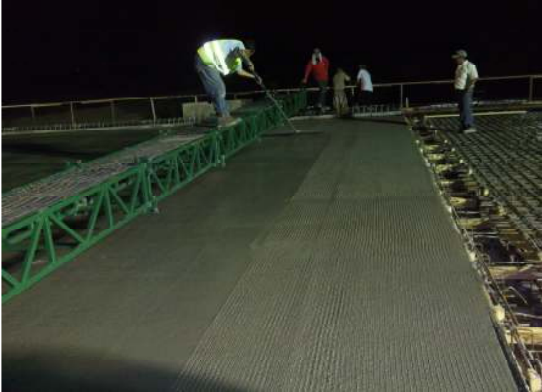
ACABADO FINAL DE LA LOSA
