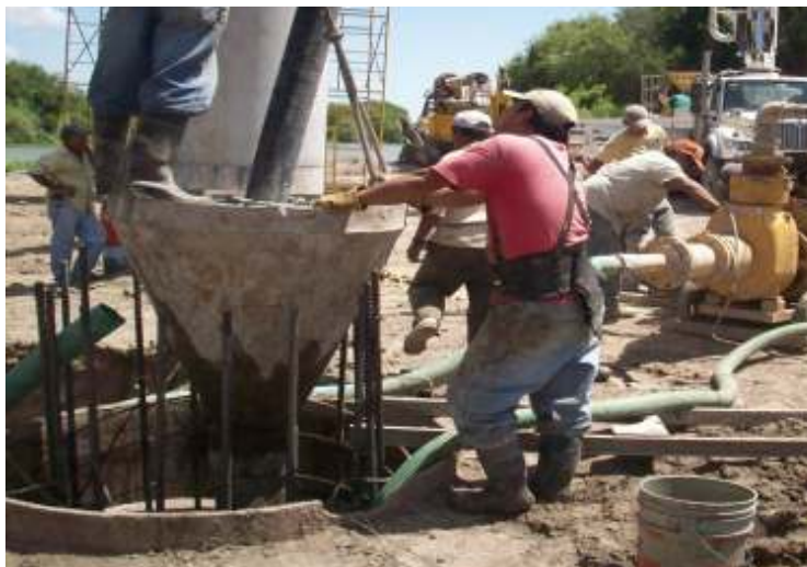
Colada de pilote
