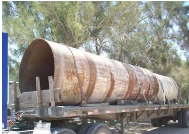
Ademe de 10 metros de longitud llegado a obra
