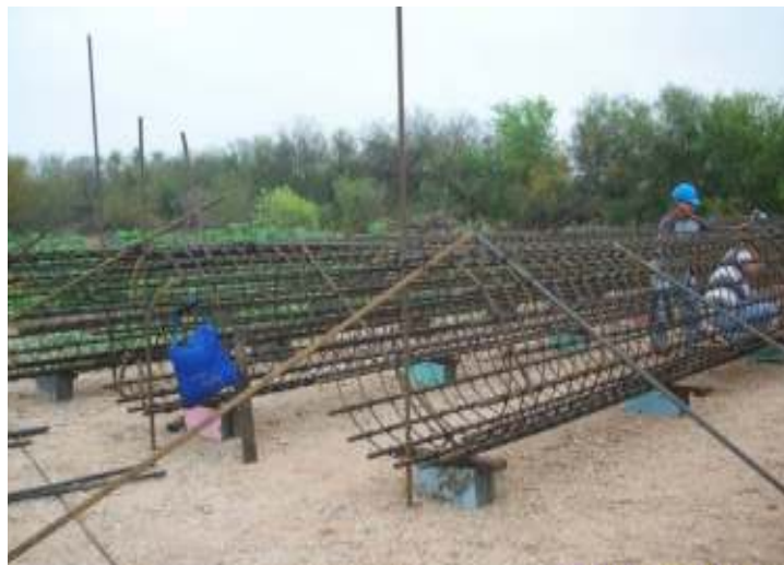
Armado de acero de refuerzo de pilote y columna
