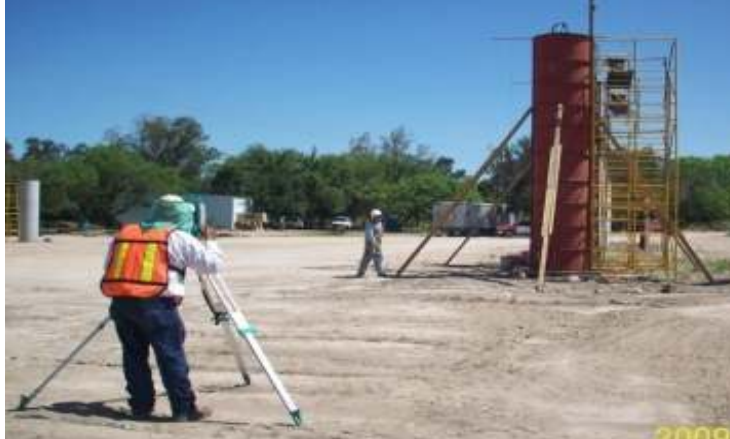
Plomeado de la columna
