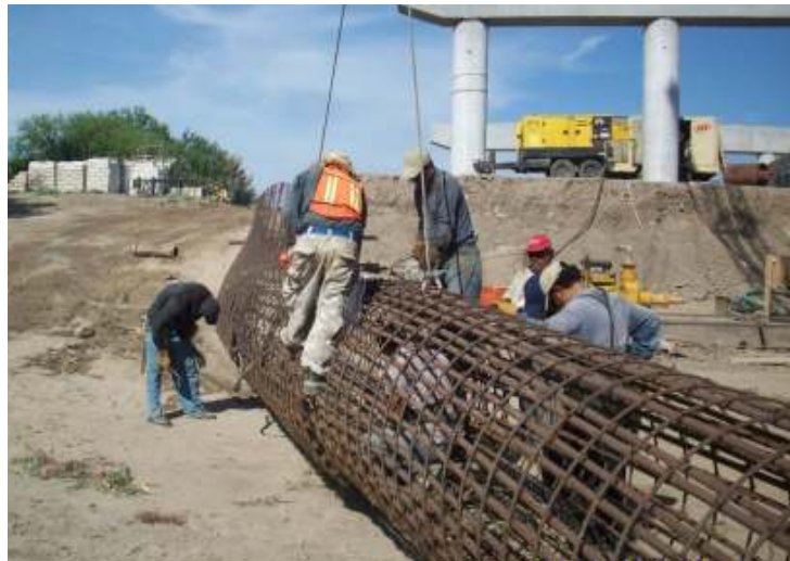
Amarre de acero para sujetar el estrobo de la grúa
