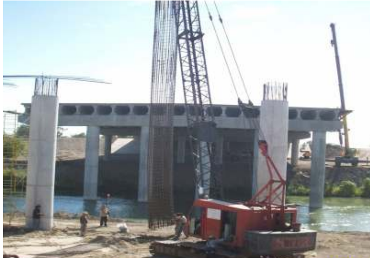
Izaje de armado de acero mediante grúa
