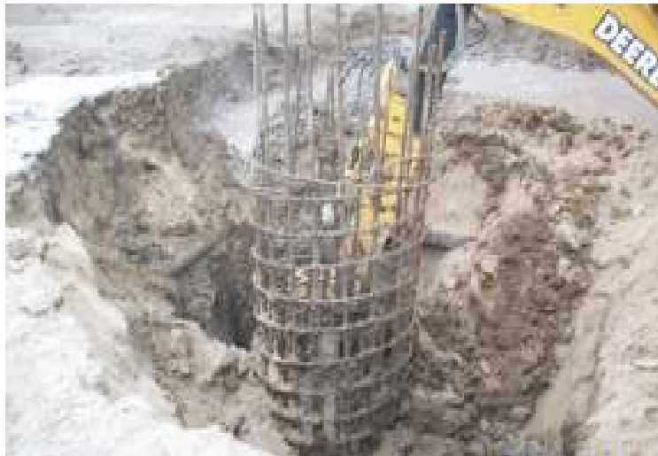
Desalojo de material y concreto.
