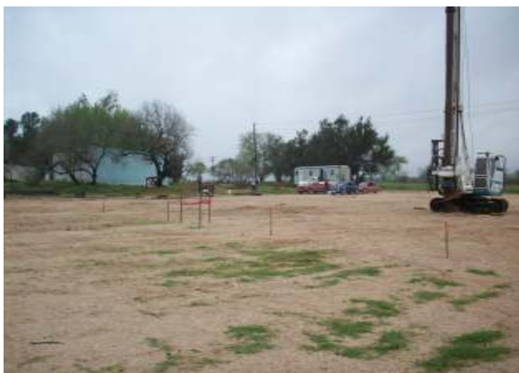
Marcas y referencias necesarias para la localización de las pilas.
