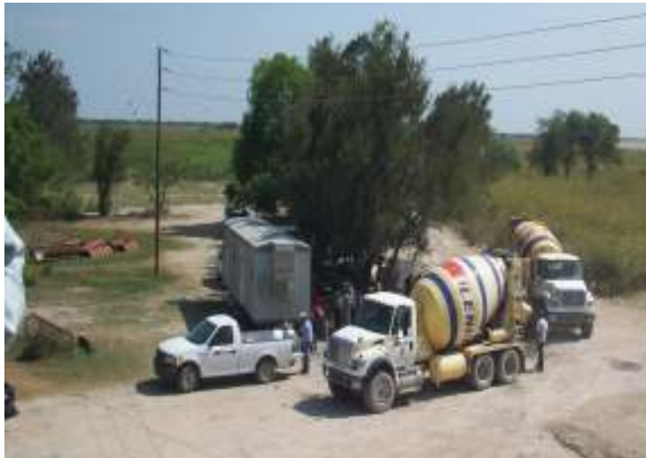
Concreto llegando a la obra
