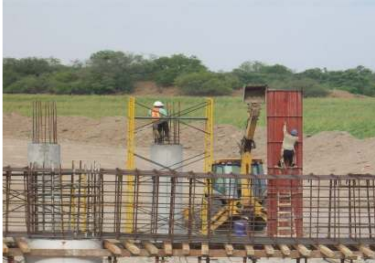
PROCEDIMIENTO CONSTRUCTIVO PARA CABEZALES
