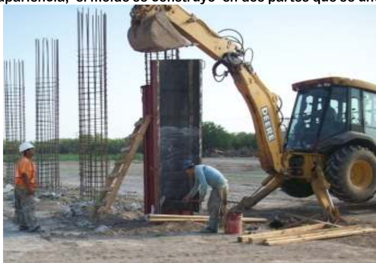
Colocación de desmoldante
