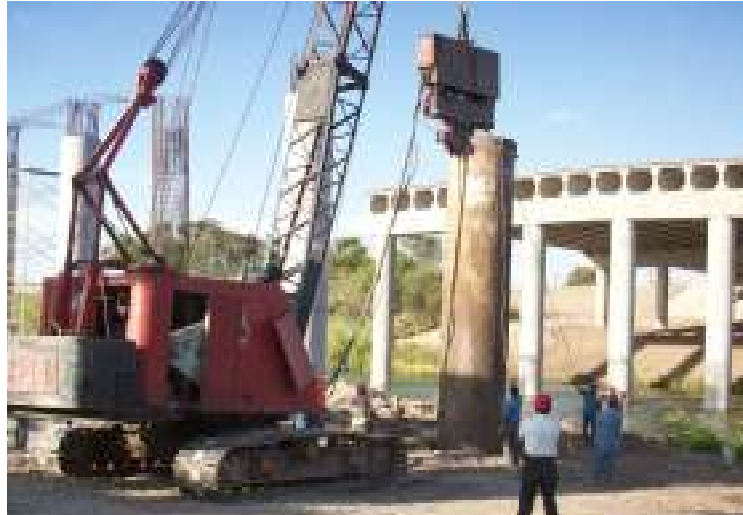
Extracción del ademe con vibrohincador
