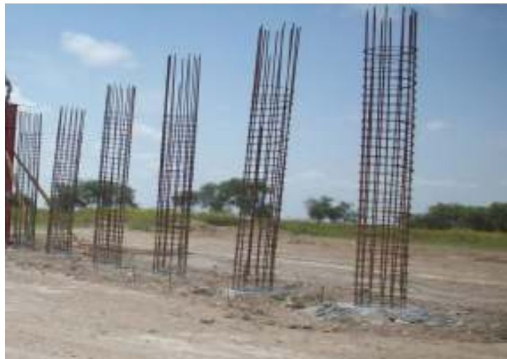
Acero de refuerzo en columnas
