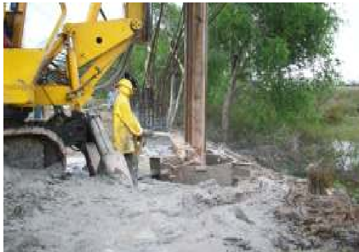
Perforación con incrustación de ademe
