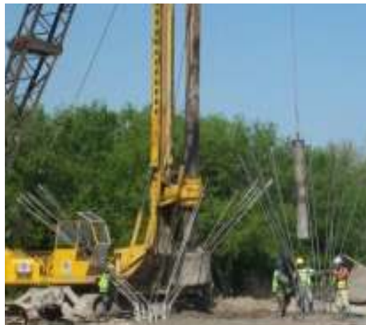
desalajo de piezas de tubo tremie
