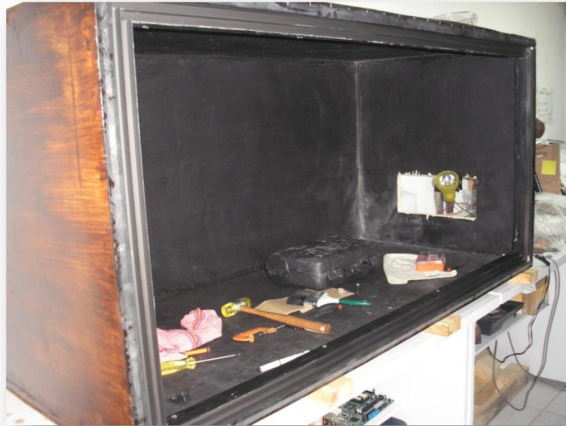
Figura 2.2.2. Etapa de construcción de la Cámara Oscura.
