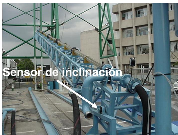
Fig. 1.8. Inclinación de la estructura.
