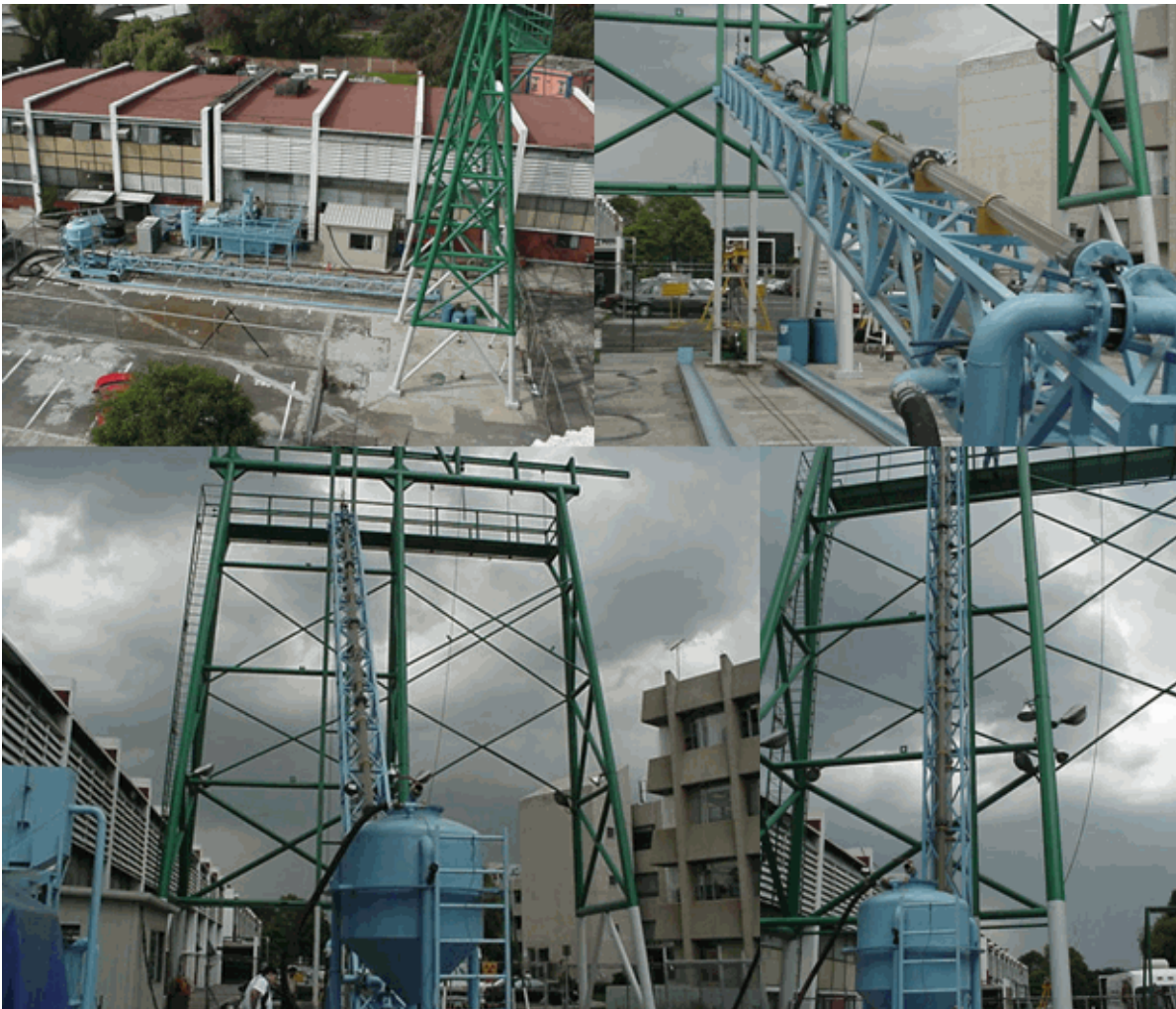
Fig. 5.3. Inclinación de la estructura experimental.
