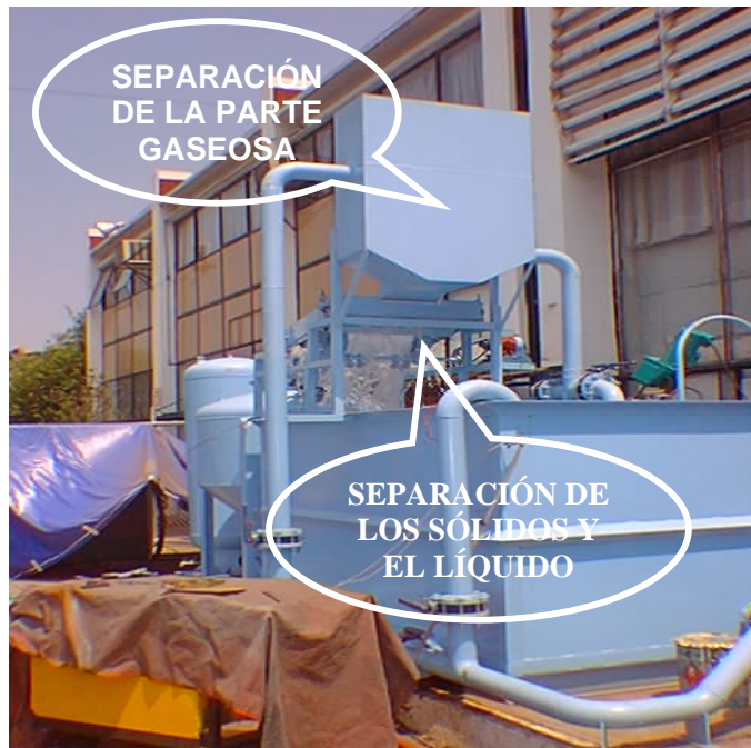
Fig. 1.7. Separador de fases.
