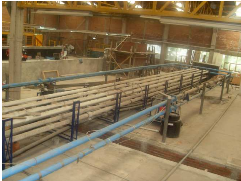
Figura 3.5: Vista lateral de la instalación física del ducto piloto
