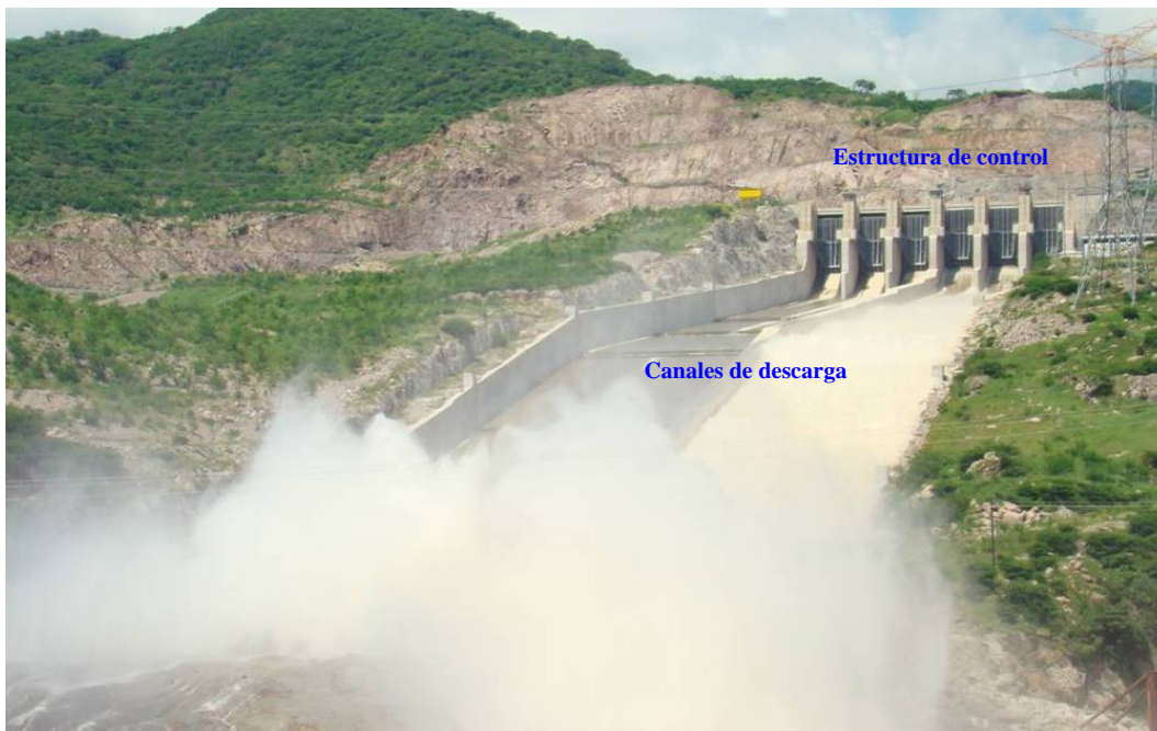
Figura II.14. Obra de excedencias.
