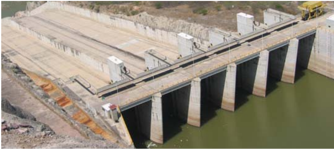
Figura II.6. Obra de excedencias.
