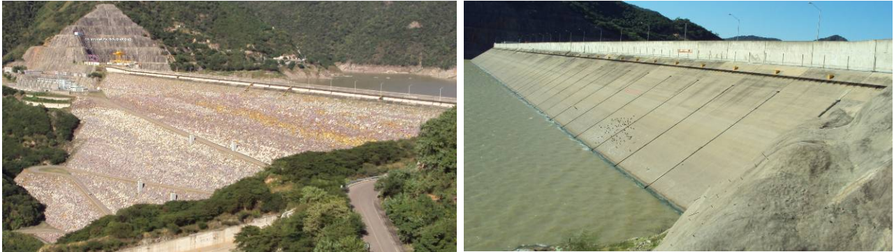
Figura II.5. Taludes aguas abajo y aguas arriba de la presa.
