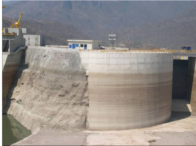
Figura V.7 Muro alabeado de la obra de excedencias.
