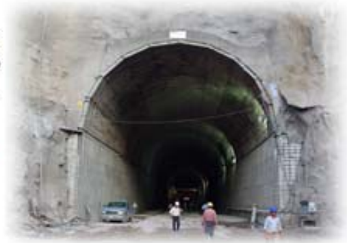
Construcción de dos túneles de desvío de 14 m x 14 m cada uno; longitud T1= 693.35m, longitud T2= 750.57m
