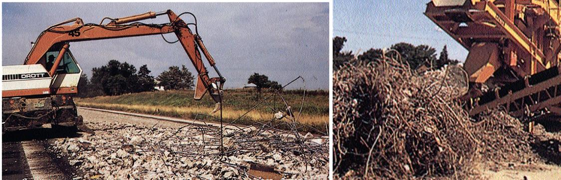
Figura 2.5 a) Retroexcavadora montada sobre orugas con cuerno de rinoceronte (rhino horn) para la remoción del acero de refuerzo,
