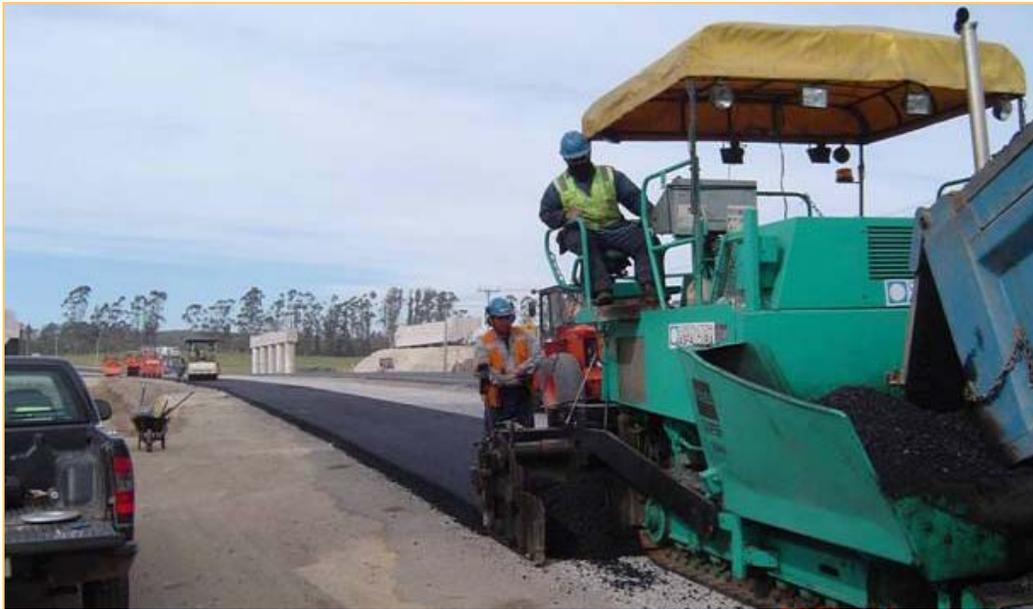
Figura 2.18 Colocación de mezcla asfáltica en caliente sobre el concreto triturado y compactado (RMI, Inc.)
