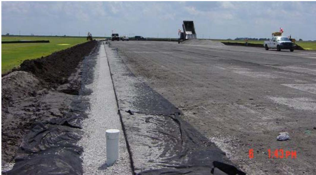
Figura 2.10 Instalación del sistema de subdrenaje en el pavimento de una aeropista previo a los trabajos de rubblizing (Asphalt Institute).
