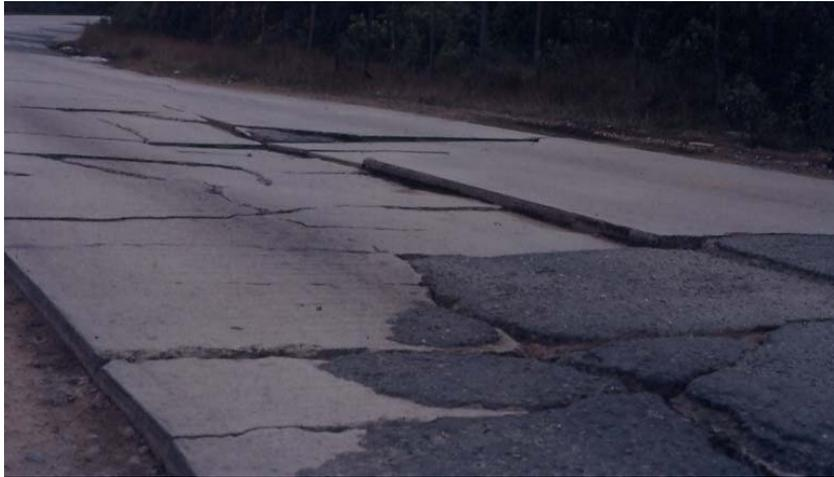
Figura 2.1 Pavimento de concreto, con secciones de bacheo de concreto asfáltico (ICPC).
