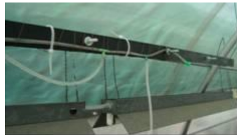
Tubería de distribución
