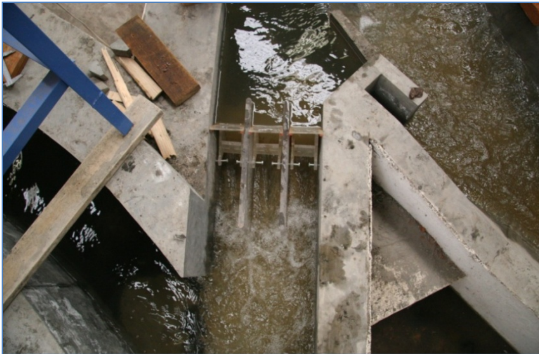
Fig. 5.2.6.1 Gasto de diseño en el TEC y compuertas operando para pasar 50 m 3 /s. Nótese el salto hidráulico en la descarga.
