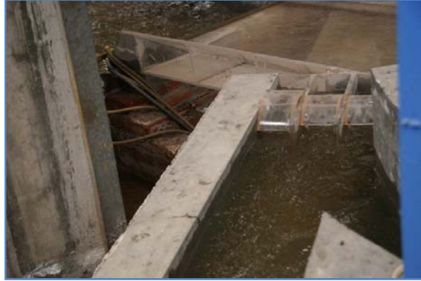
Fig. 5.1.3.1.4 Nivel del agua en la zona de entrada a la alcantarilla, con las compuertas existentes totalmente abiertas
