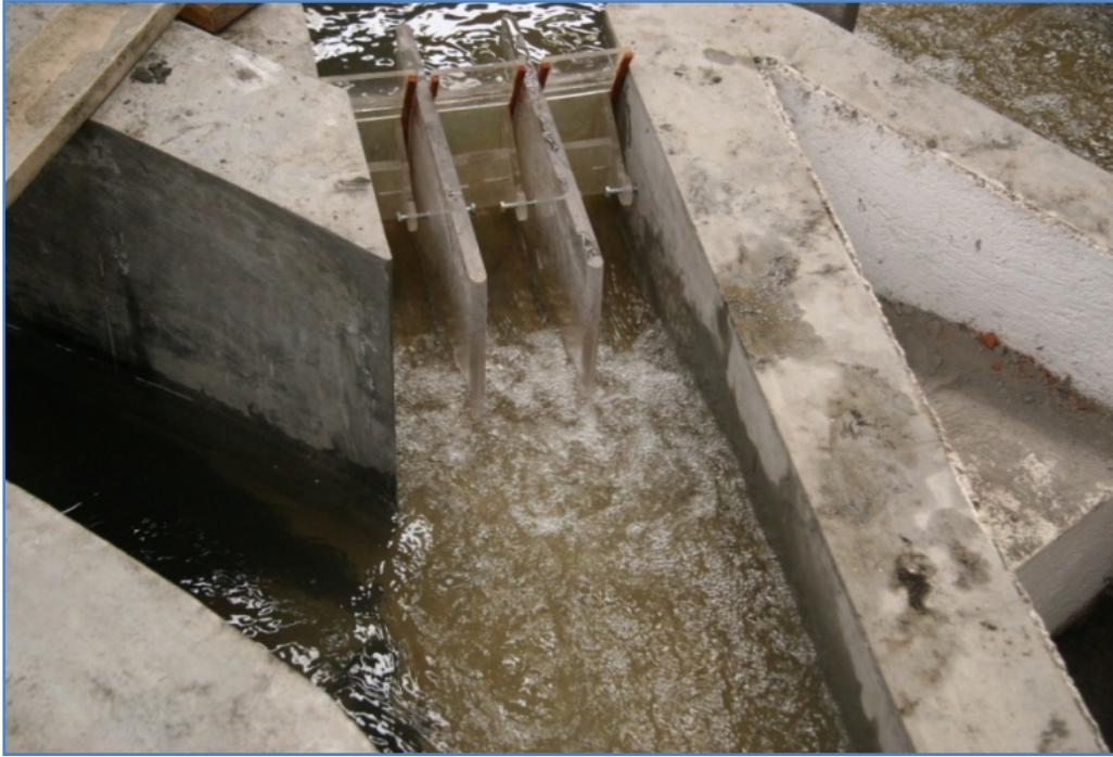
Fig. 5.2.6.2 Detalle del salto hidráulico en el TEC para el gasto de 50 m 3 /s a las alcantarillas
