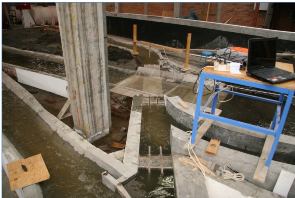
Fig. 5.2.3.2.2 El TEC con gasto de diseño, compuertas totalmente abiertas. Medición del tirante aguas abajo de la alcantarilla
