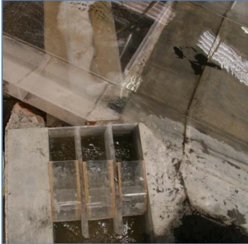
Fig. 3.4.5 Entrada a la alcantarilla
