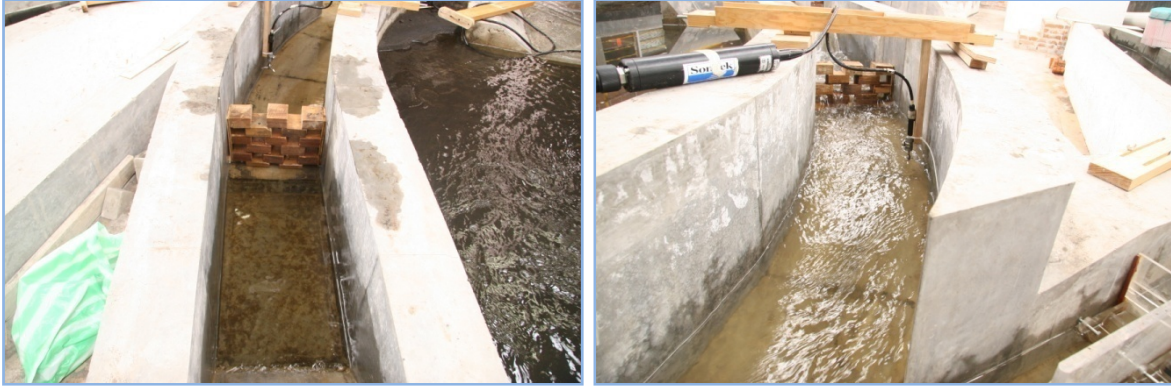
Fig. 6.4.2.1 Estructura Celosía a la salida del tanque amortiguador
