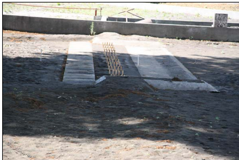
Fig. B.3.3 Presa tipo indio modificada
