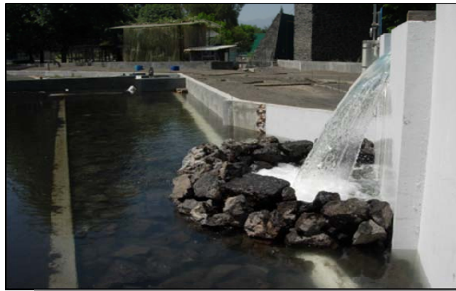
Fig. B.3.5 Vertedor del modelo físico en funcionamiento
