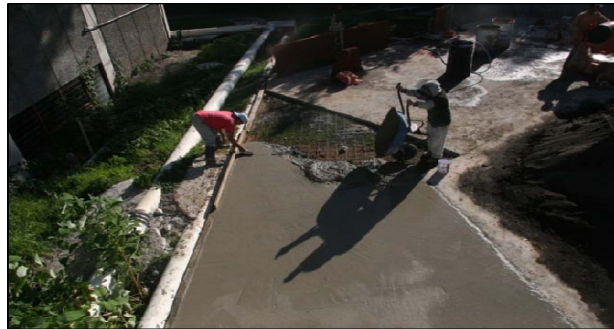
Fig.B.2.3 Obra civil, construcción de losas y muros.
