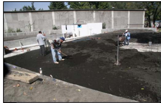
Fig. B.2.6 Conformación y compactación del modelo físico.
