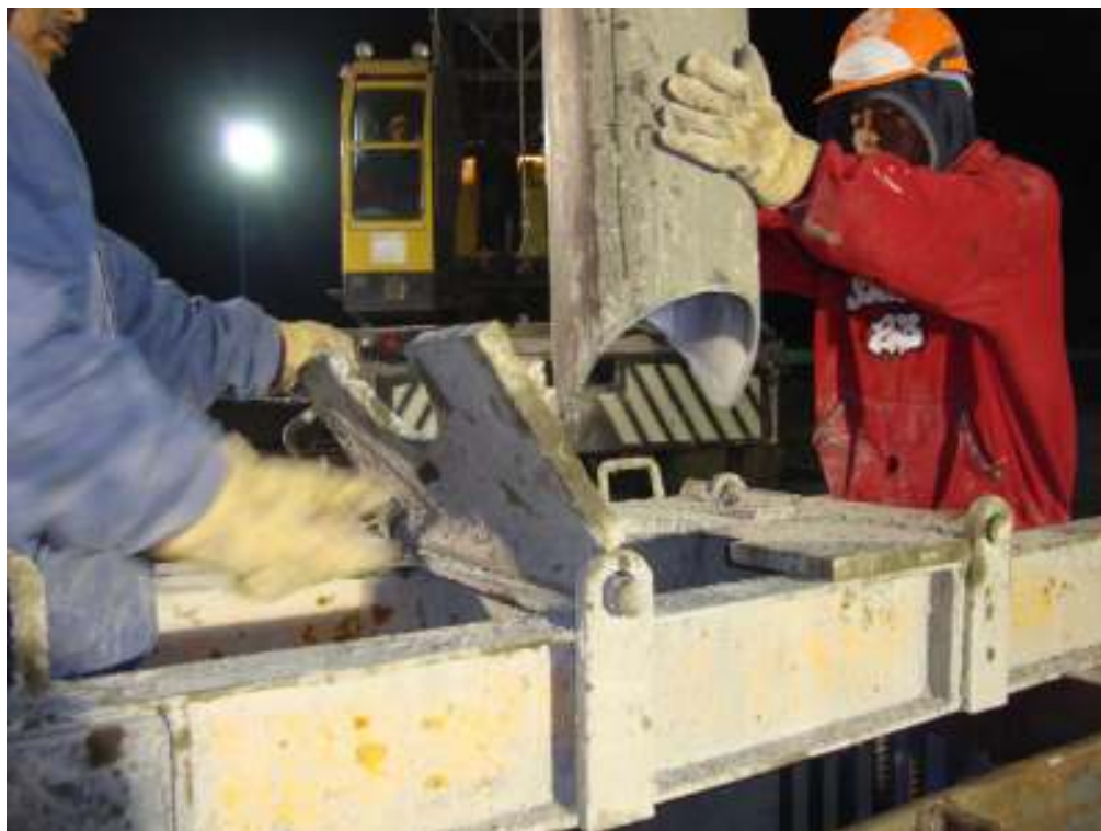
Se coloca tubo con boca de pescado en trampa de tubería Tremie.
