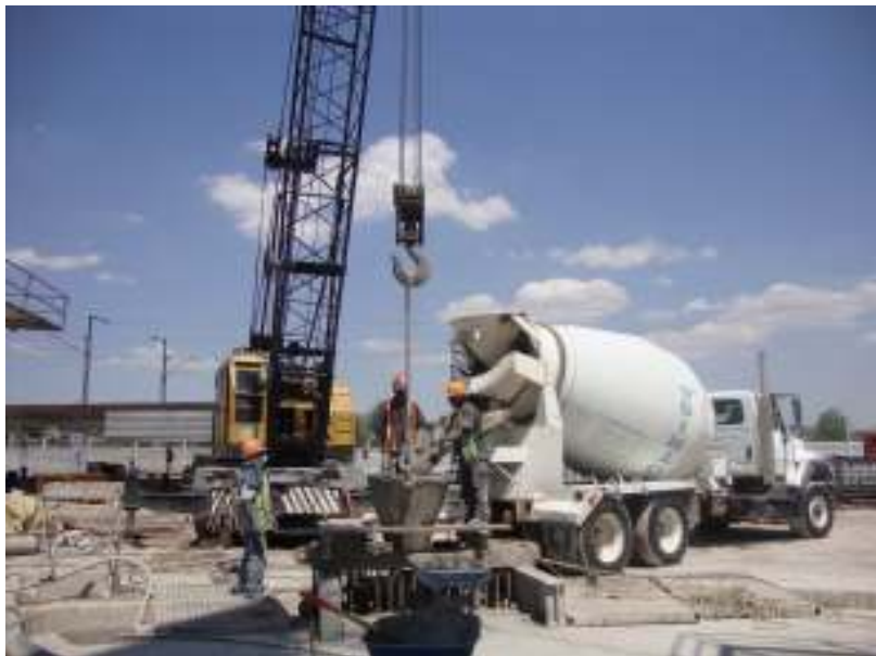
Camión revolador tirando concreto en cono de tubería Tremie, el cual está suspendido de la grúa.
