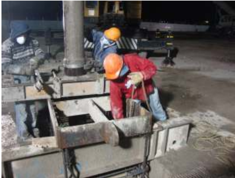
Se mide columna por llenar con sonda.
