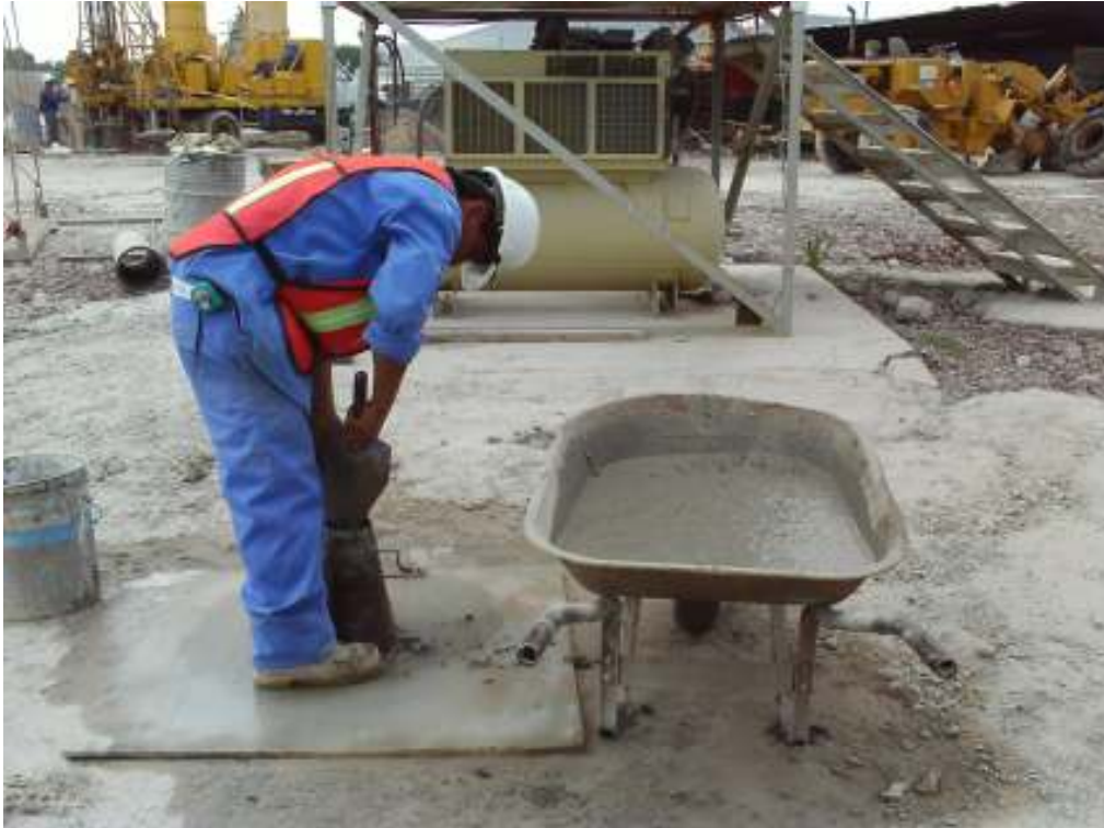
Se realiza prueba de extensibilidad del concreto.
