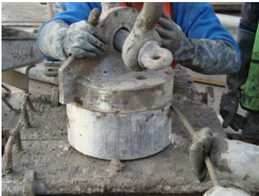
Se coloca cable de acero para acoplar campana con tubo Tremie.
