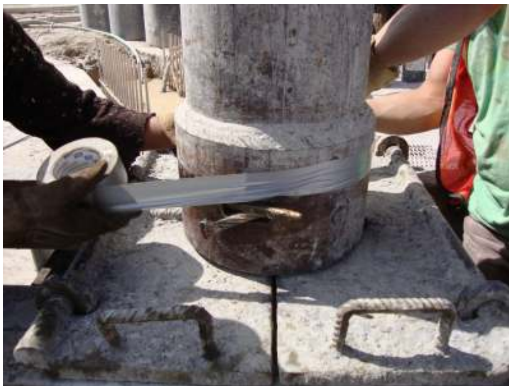
Se coloca cinta adhesiva para sellar unión entre tubos.
