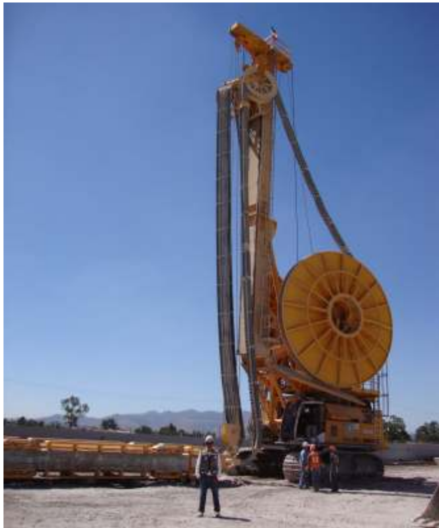
Desmantelamiento de hidrofresa al término de las excavaciones correspondientes a la Lumbrera 19 del Túnel Emisor Oriente.
