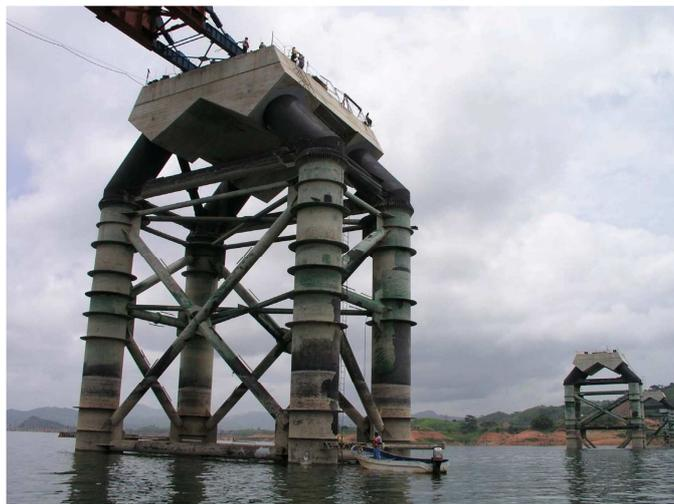
Figura 1.4 Subestructura del puente Chiapas pilas tipo “jacket”
