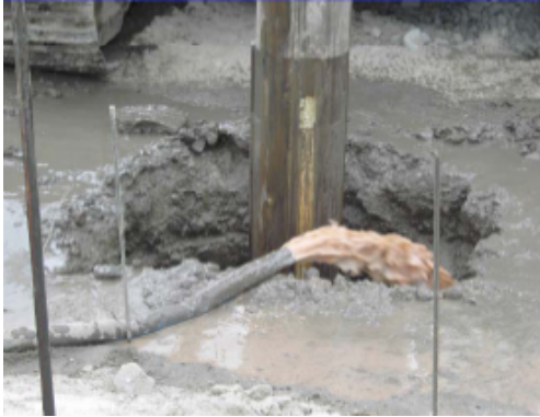
Fig. 48. Estabilización con lodo bentonítico
