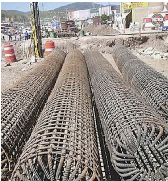
Fig. 62. Izq. Habilitado y almacenamiento de acero. Medio: Izaje de acero de refuerzo. Der.: Colocación de acero de refuerzo en la perforación
