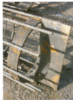
Fig. 66. Barra metálica auxiliar para vibrado del armado. (Hudelmaier and Küfner 2009)
