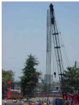
Fig. 62. Izq. Habilitado y almacenamiento de acero. Medio: Izaje de acero de refuerzo. Der.: Colocación de acero de refuerzo en la perforación
