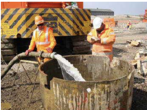
Fig. 47. Estabilización con agua
