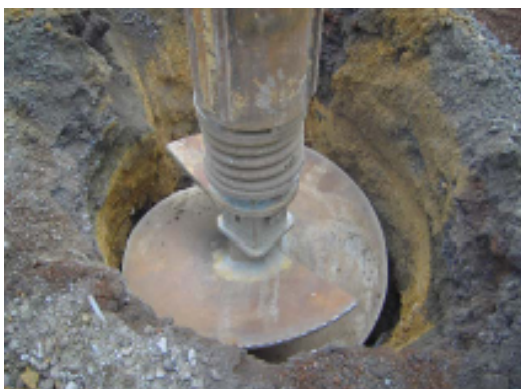
Fig. 50. Perforación sin empleo de ademe metálico
