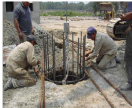
Fig. 62. Izq. Habilitado y almacenamiento de acero. Medio: Izaje de acero de refuerzo. Der.: Colocación de acero de refuerzo en la perforación
