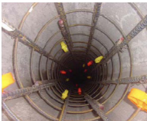
Fig. 65. Sepradores en la jaula de acero
