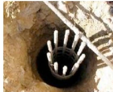
**Fig. 1. Acero de refuerzo en perforación**
