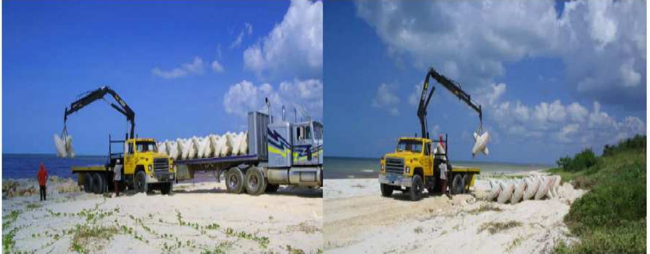
Figura 13. Transporte y descarga en el sitio de la obra
