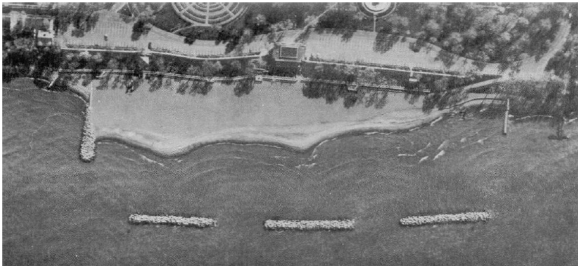
Figura 22. Obras paralelas separadas de la línea de costa
