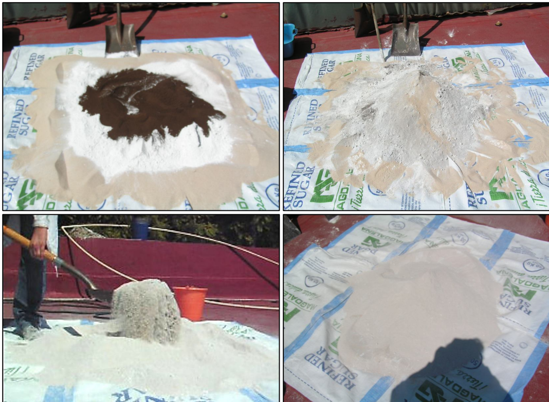
Figura 12. Conformación del suelo artificial
