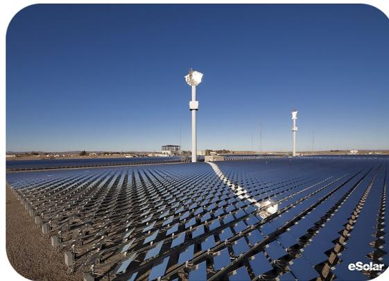
Fig. 5: Concentrador solar de campo de helióstatos [33]
