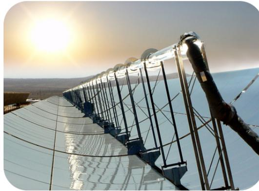
Fig. 3: Concentrador solar de canal parabólico [33]
