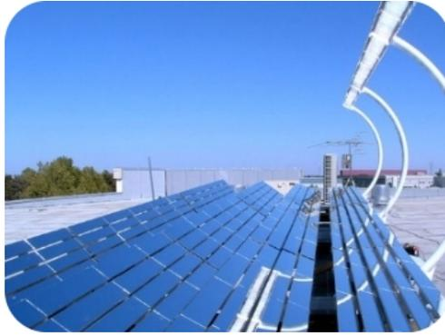
Fig. 4: Concentrador solar tipo Fresnel [33]
