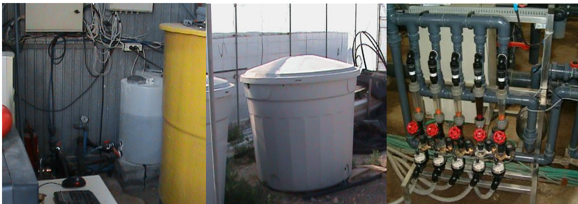
FIG 54 Izquierda, procesamiento de datos de fertirrigación; al centro, contenedores de solución nutritiva para fertirriego. Derecha, dosificador para fertirrigación.
