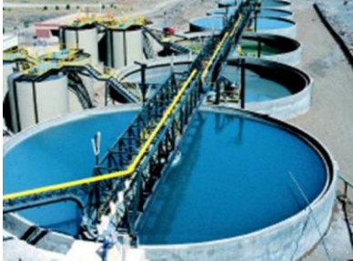
FIG 17 Depósitos de agua. Imag. Int., 2011.
