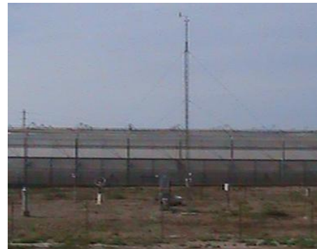
FIG 53 Estación climática ubicada en la Estación Experimental de Cajamar, unidad Palmerillas, Almería. España.
