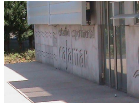
FIG 37 Estación Experimental de la Fundación Cajamar. El ejido, España.
