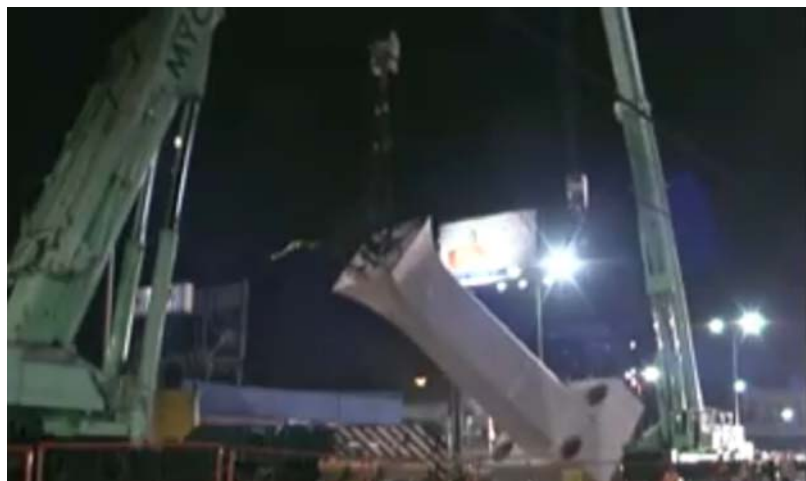
Figura 2.6 Izado de columna
