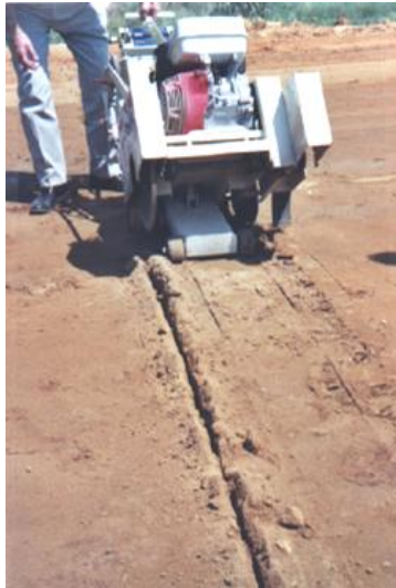
Figura 3.11. Precorte de la base estabilizada (George, 2001)
