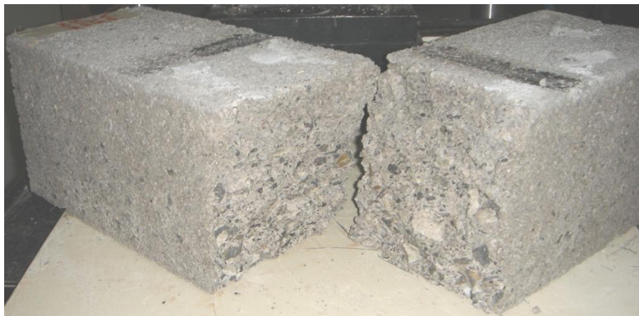
Figura 4.27. El curado de los especímenes contribuyó a mejorar la textura de las caras en la viga, a pesar de ser un material granular
