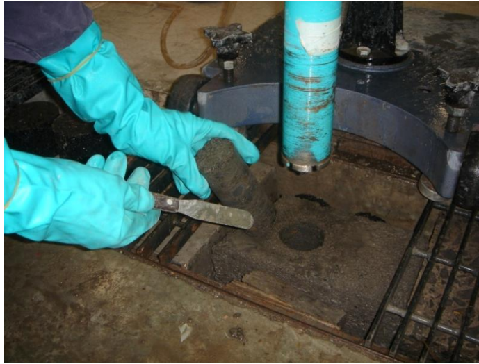
Figura 6.61. Extracción de núcleos procedentes de vigas ensayadas
