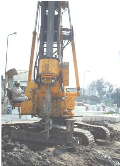
Fig. 3.2. Perforadora helicoidal montada sobre orugas
