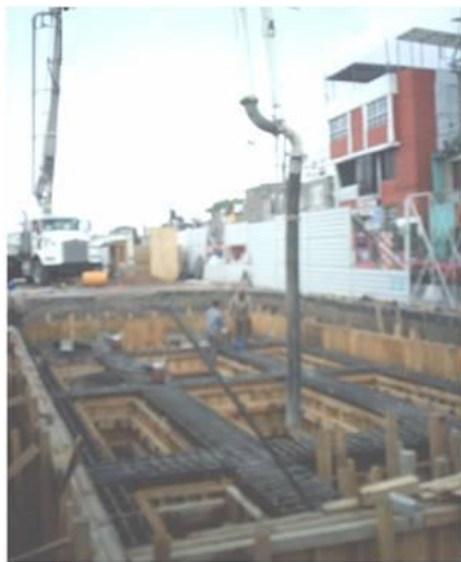
Fig. 3.25. Colado de Zapatas
