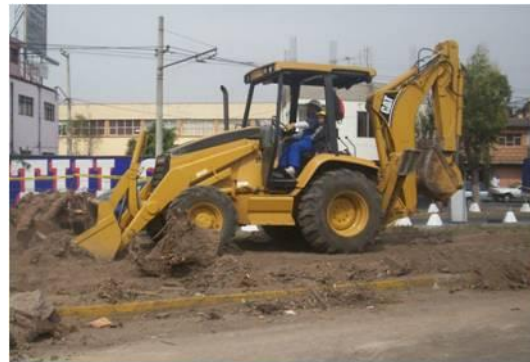
Retiro de la demolición
