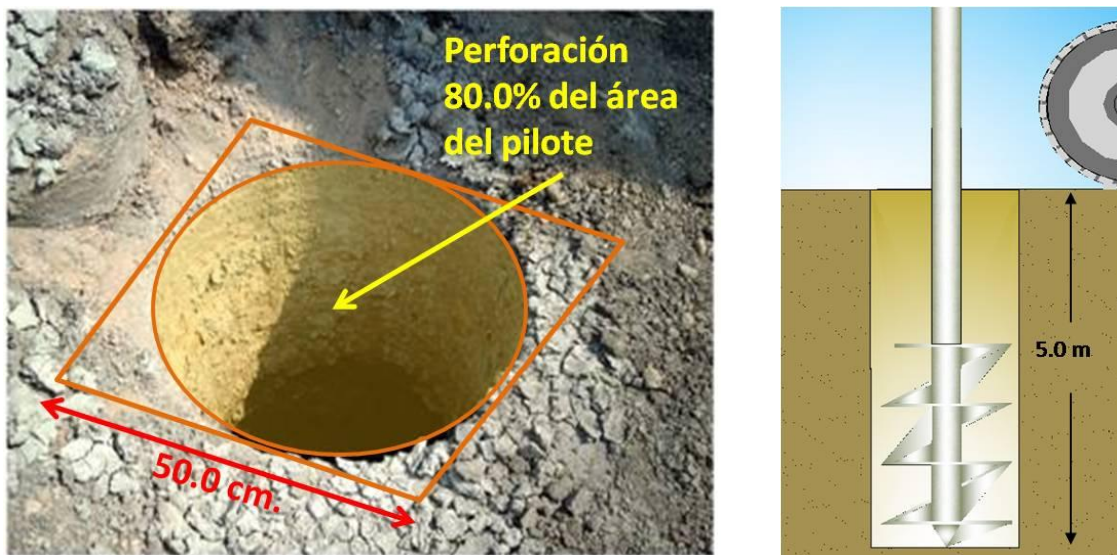
Fig. 3.4. Perforación previa para el lanzado e hincado de pilotes
