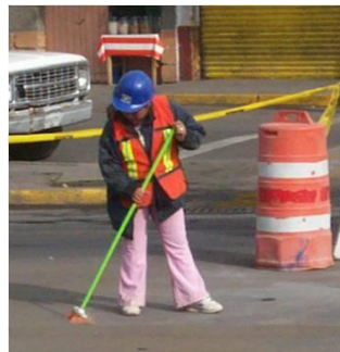
Trabajos de limpieza
