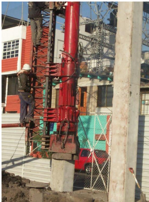
Fig. 3.8. Martillo de baja velocidad para el hincado de pilotes
