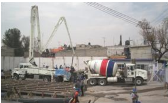
2.8 (a) Colado de Pilotes
