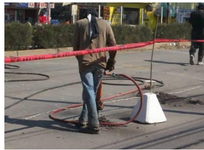
Colocación de bollas y cordones para el confinamiento
