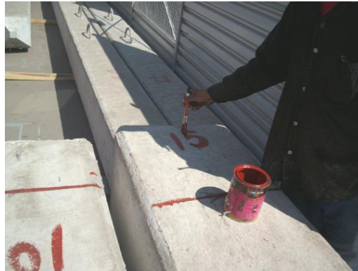
Fig. 2.12. Marcado de Pilotes
