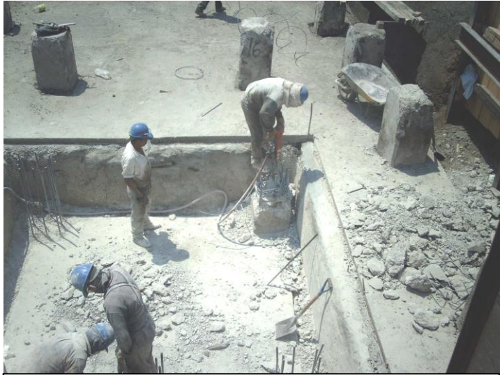
Fig. 3.21. Descabece de Pilotes
