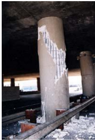
Figura 1.4 Fallas por cortante, sismo de Northridge en 1994
