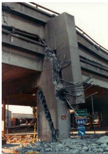
Figura 1.1 Falla en la unión del traslape en la base de la columna, sismo de Loma Prieta 1989
