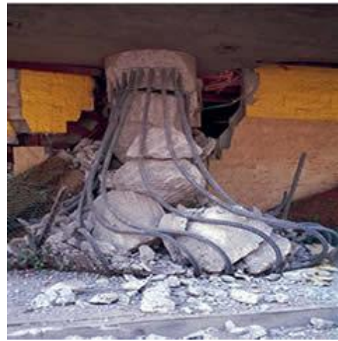
Figura 1.4 Fallas por cortante, sismo de Northridge en 1994
