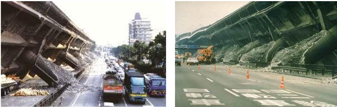
Figura 1.2 Falla a flexión en la base de las columnas del puente Hanshin, sismo de Kobe en 1995
