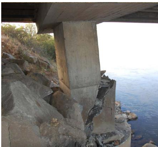
Figura 1.5 Fallas por cortante, sismo de Chile en 2010
