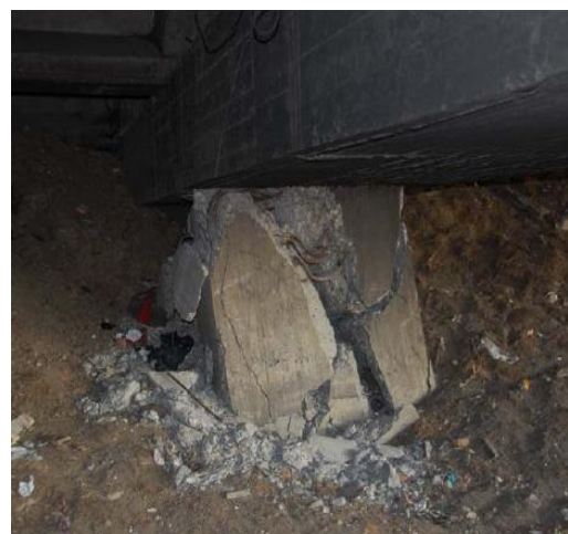
Figura 1.5 Fallas por cortante, sismo de Chile en 2010
