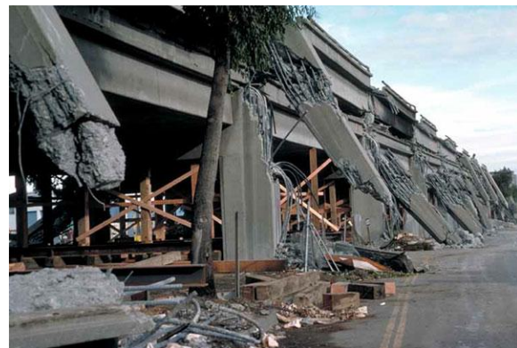
Figura 1.1 Falla en la unión del traslape en la base de la columna, sismo de Loma Prieta 1989
